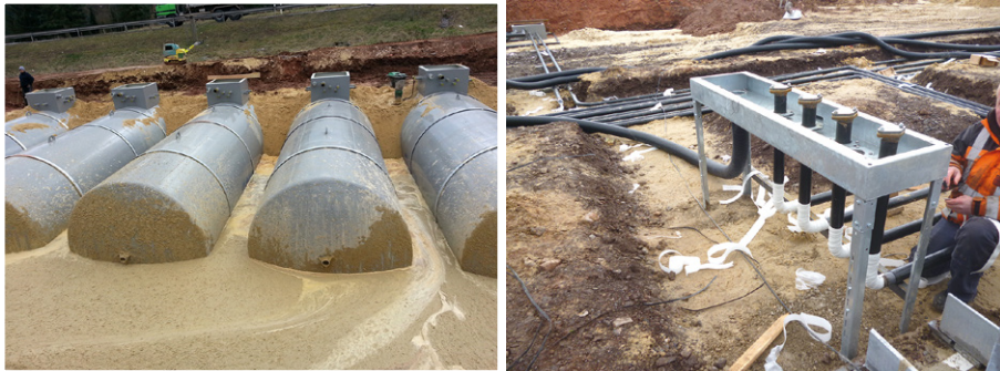
Abbildung 66: Tanklager und Zapfsäulengründungen einer Tankstelle (Fotos: Achim Hamann)
