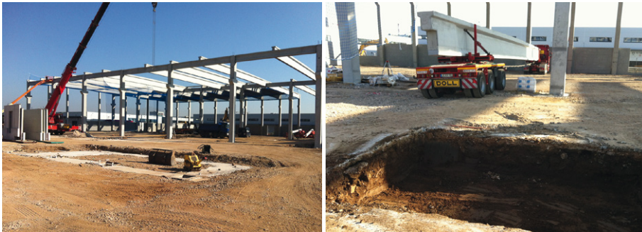
Abbildung 69: Beispiel zu einer Bauunterbrechung infolge schlechten Untergrunds (Fotos: Achim Hamann)
