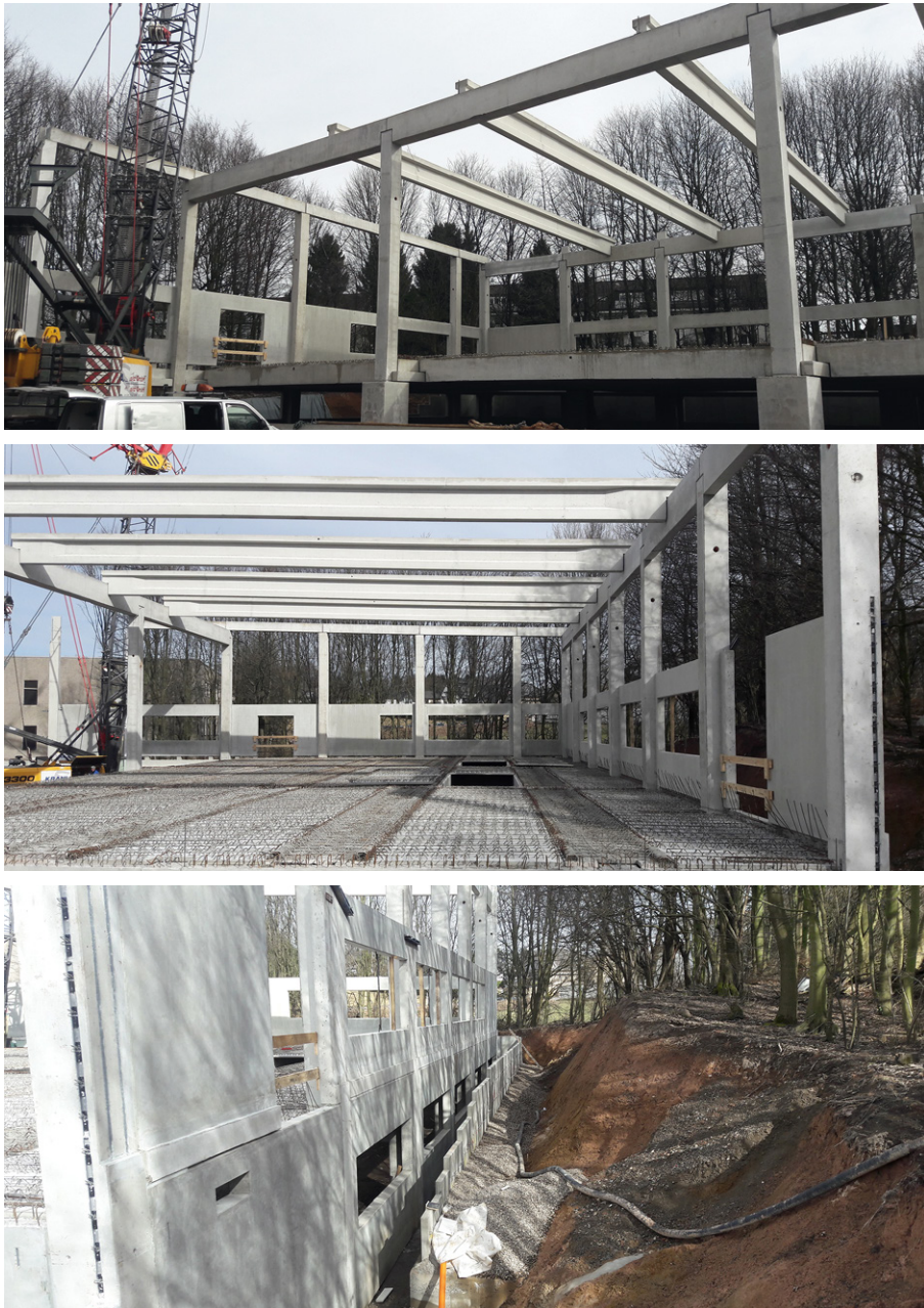
Abbildung 72: Beispiel zu einer Stahlbeton-Fertigteilkonstruktion (Fotos: Achim Hamann)
