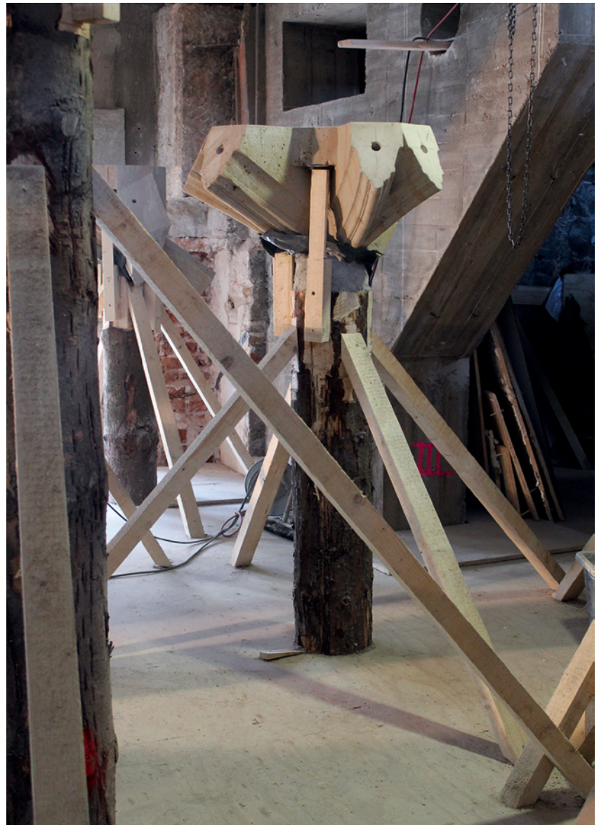
Bild 17 Lehrgerüst für den Versatz der Rippenknoten aus unbesäumten Baumstämmen mit Zwickelstempel zur exakten Positionierung und Haltung nach Vorgabe von Höhen- und Lagepunkten der steintechnischen Werkplanung gemäß der Vorgaben von Bauer/Lauterbach [Foto: Thomas Bauer]
