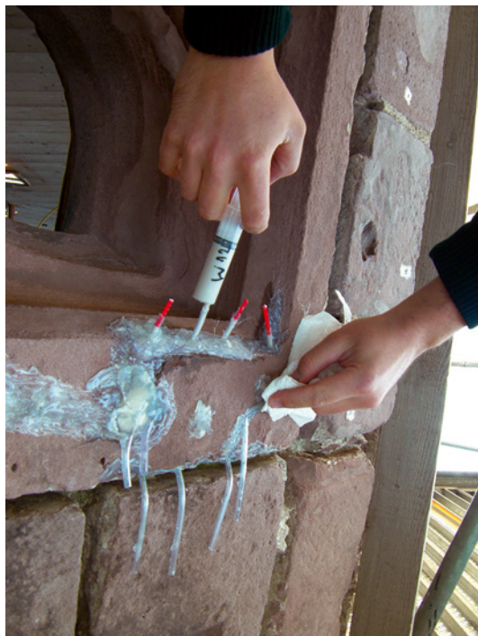
Bild 15 Rissverfüllung per Injektion
