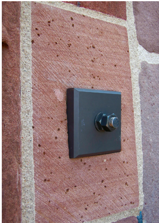
Bild 13 Detail der Hightech Titanverschraubung
