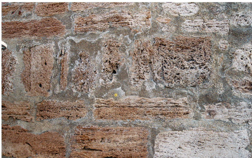
Bild 7 Detailansicht 1 von der Westseite – Ausblühungen auf Verfugmörtel
