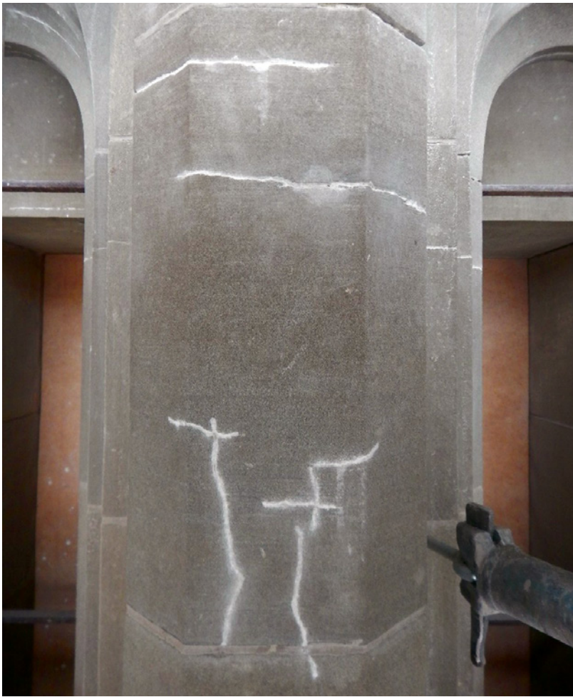
Bild 8 Das Konzept aus Vorfestigung der Riss- und Schalenflanken, Verfüllungen mit Steinsilikatkleber und Kittungen mit Acrylat vergütetem Schlamm-mörtel hatte auch den Vorteil, dass Nachfestigungen auf ein Minimum reduziert werden konnten.
