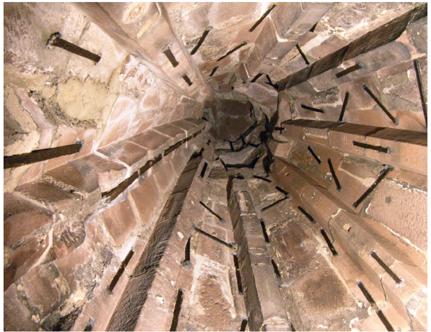
Bild 7 Blick in das Innere der Turmspitze mit zahlreichen Eisenklammern
