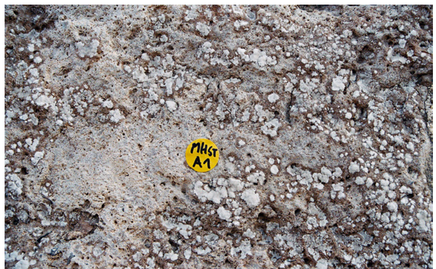
Bild 8 Detailansicht 2 von der Westseite – punktuelle Gipsablagerungen auf Travertin
