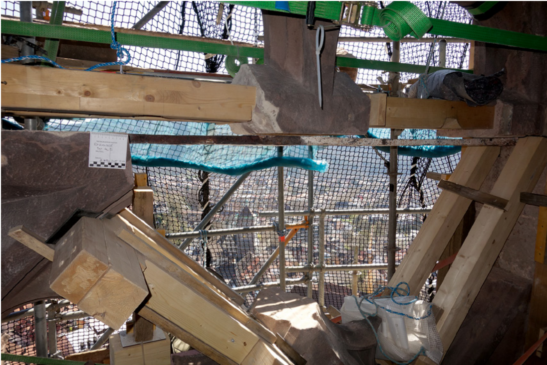
Bild 11 Baubehelf und Blick auf den freiliegenden Ringanker
