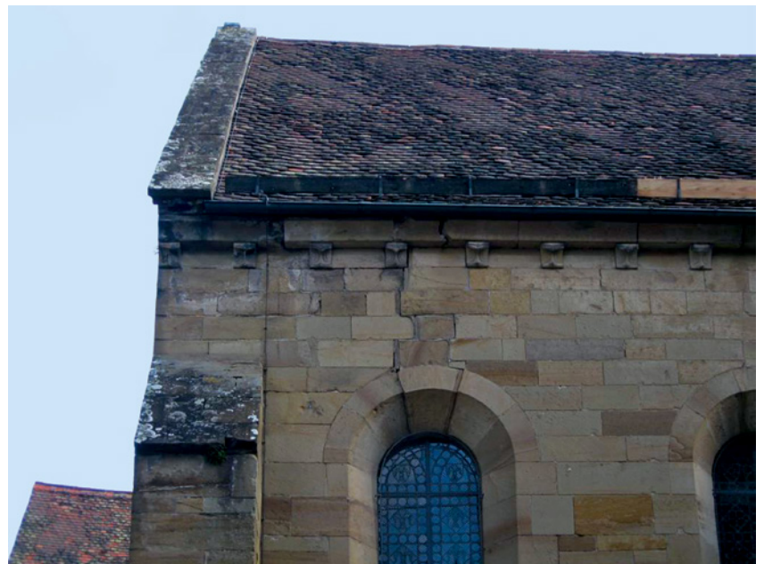
Bild 9 Nordwestecke, Riss über Fenster
