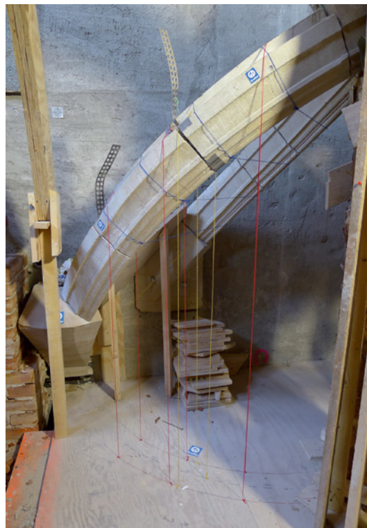
Bild 14 Schlingrippenherleitung am Probejoch, sog. Strickmodell von Thomas Bauer; Jörg Lauterbach: Aufriss der Schlingrippenfigur im Grundriss (rote Stricke), geometrische Lagebezug der Rippenfuge (gelbe Stricke) und Höhenlagen der Bogenaustragung (blaue Stricke) [Strickmodell Thomas Bauer; Jörg Lauterbach; Foto: M. Ventas]
