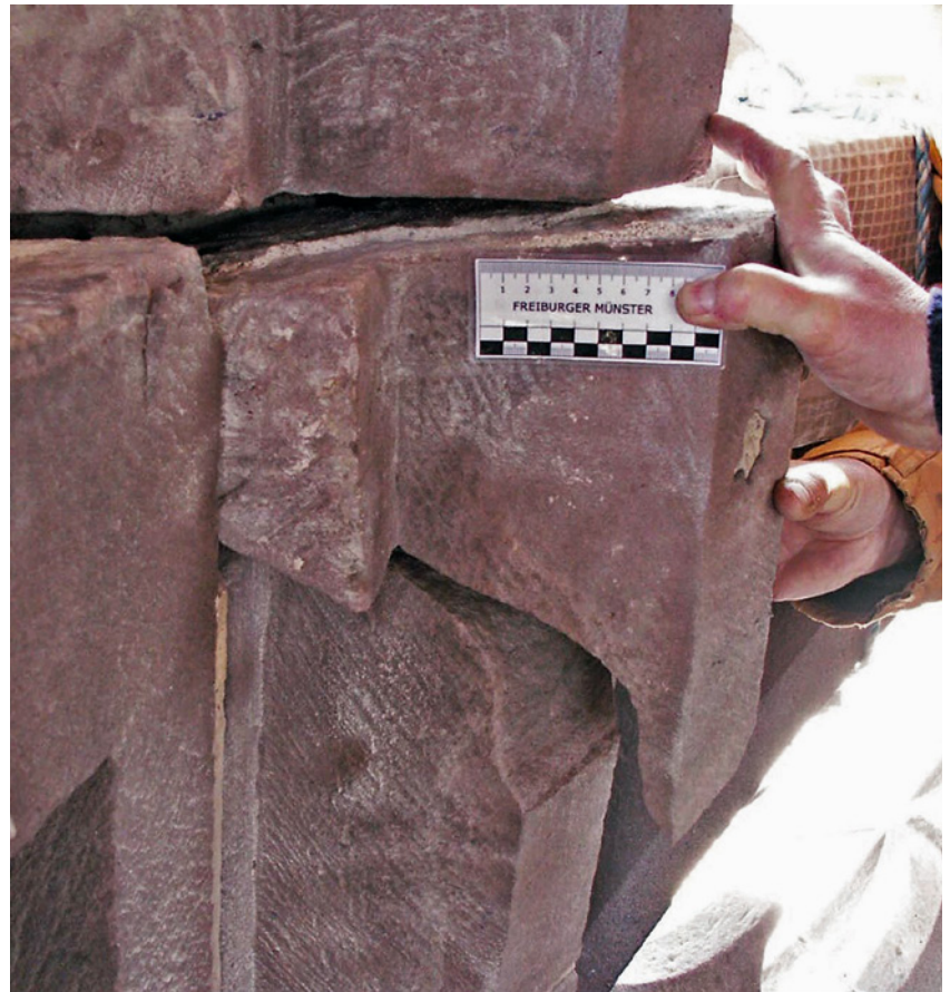
Bild 11 Gelöstes Stück eines Ecksteins
