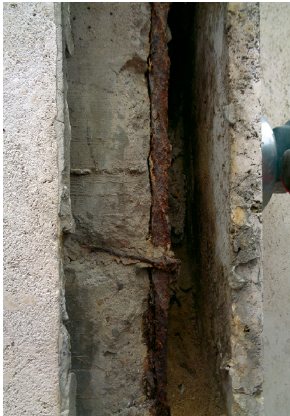
Bild 5 a+b Köln, Fassade mit vorgehängten, hinterfüllten Fassadenplatten, Fugen dauerelastisch ausgebildet, links: gelöste Fassadenplatte, Hinterfüllung mit oxidiertem Stahlbewehrung und Anker, dahinter Stahlbetonwand, rechts: Prinzipskizze des Aufbaus
