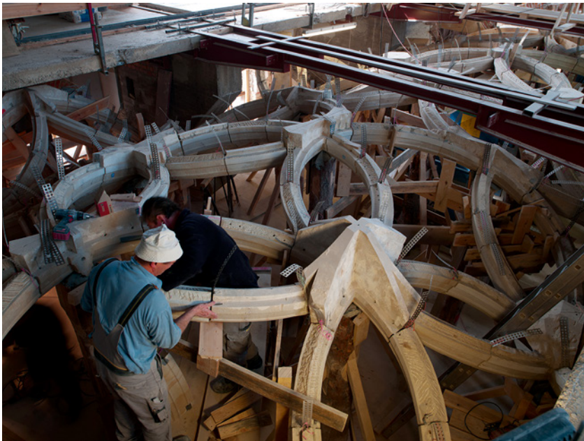
Bild 18 Nach dem Versatz der Rippenknoten ist das Rippenwerk im Prinzip bezüglich aller Rippenaus- und -einfälle hinsichtlich der Höhen und Grundrisslage definiert; danach können die Rippenstücke freihändig zwischen die Knoten eingepasst werden, die Behelfshölzer (Bretter/Knaggen) geben die Form nicht vor, sondern unterstützen lediglich temporär die Lagerung der Werkstücke (Foto: Thomas Bauer)
