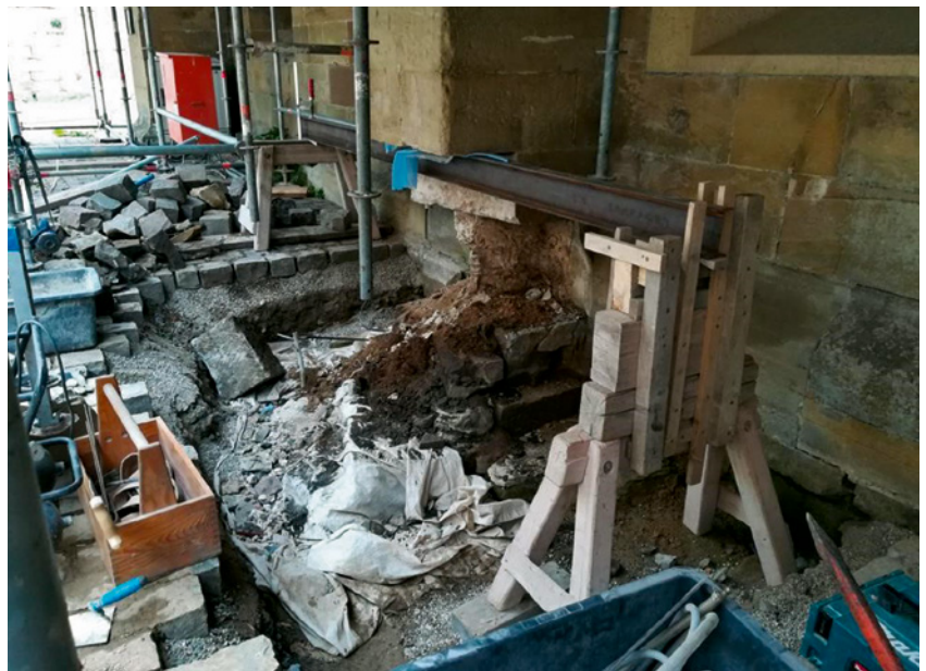
Bild 12 Neuersatz Pfeilerfuß
