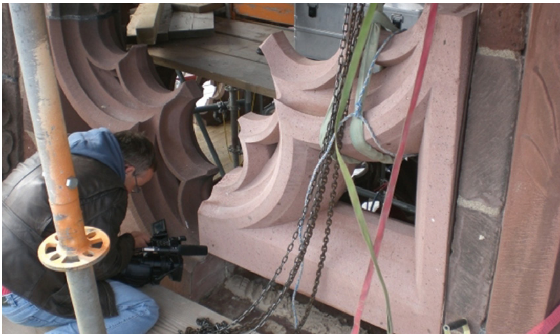
Bild 21 Einbau eines neu geschlagenen Maßwerksteins
