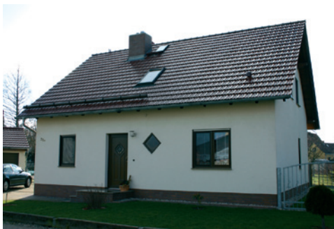
Abbildung 7-11 Wohnhaus zum Zeitpunkt der Thermografie und während der Bauphase, oberhalb der Fenster befindet sich der gedämmte Rollladenkasten und der umlaufende Ringbalken (U-Schalen mit Stahlbeton)
