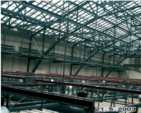
Abbildung 7-51 Druckbogen-Zugband-Konstruktion eines Luftgeschosses
