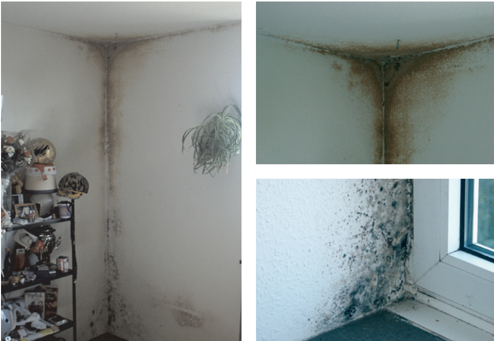
Abbildung 6-15 Extreme Schimmelpilzbildungen an Außenwandecken und im Fensterlaibungsbereich
