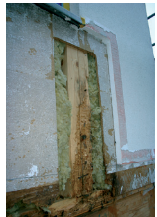
Abbildung 7-24 Wohngebäude mit geöffneter Untersuchungsstelle in Höhe der Geschossdecke. Die Außenkonstruktion ist bis zur Wärmedämmung entfernt.
