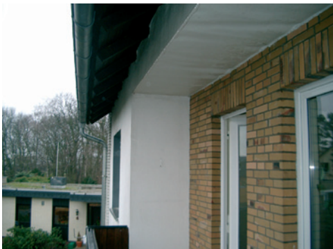
Abbildung 7-3 Außenansicht im Bereich des Balkons mit der im Balkonbereich durchlaufenden Betondecke
