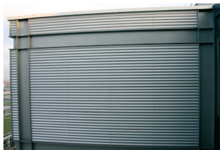
Abbildung 7-53 Ansicht der hinterlüfteten Außenwandbekleidung mit Wellstruktur. Der Betrachtungswinkel ändert sich kontinuierlich von Welle zur Welle von 0° bis 90° (vgl. auch Abbildung 2-14).
