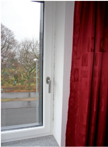
Abbildung 7-69 Überblick über das Gebäude mit einer Verblendfassade. Am Übergang Fensterrahmen zur Wandlaibung wurden vom Mieter Schimmelpilzbildungen gerügt.
