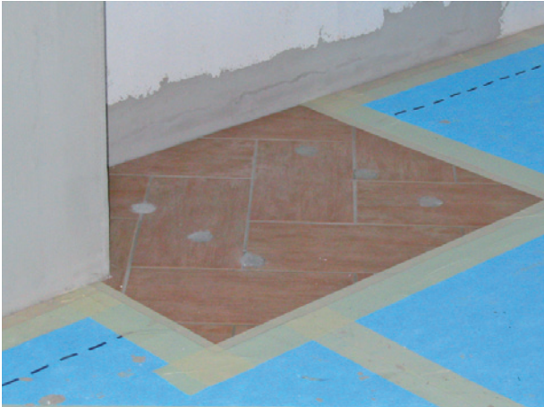
Abbildung 7-44 Anordnung der Bohrlöcher zur Durchleitung der Eigenlast bis auf die Betonbodenplatte; fertig aufgebauter Kamin mit erstem Anheizen
