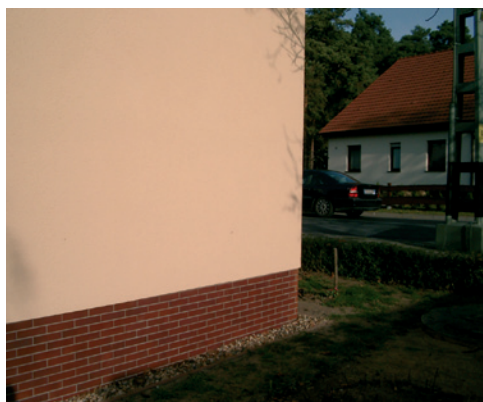
Abbildung 7-60 Aufnahme nach Durchführung von Wärmedämm-Maßnahmen am Sockel (6 cm, WLG 040, Stand: November 2005)
