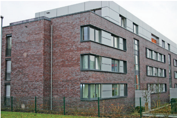
Abbildung 7-69 Überblick über das Gebäude mit einer Verblendfassade. Am Übergang Fensterrahmen zur Wandlaibung wurden vom Mieter Schimmelpilzbildungen gerügt.
