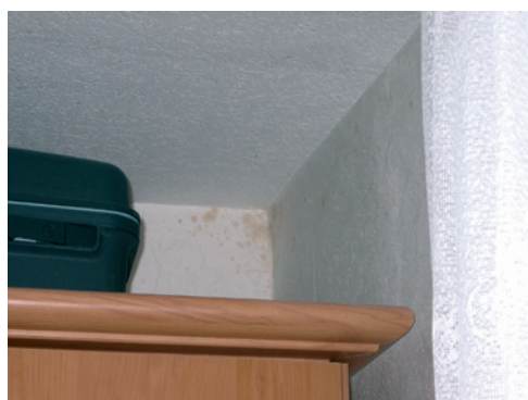
Abbildung 7-17 Beginnende Schimmelpilzbildung im Eckbereich
