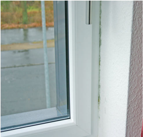
Abbildung 7-70 Übergang zwischen Laibung und Rahmen: Hier zeigt sich die Temperaturverteilung ungewöhnlich kühl. Anmerkung: Durch die Wirkung der spiegelnden Reflektion sieht sich der Thermograf häufig selbst im Thermogramm.
