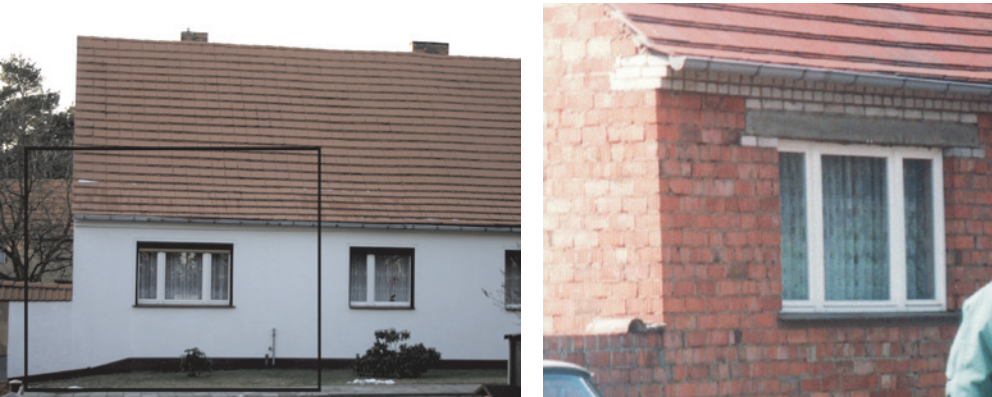
Abbildung 7-5 Mauerwerkskonstruktion mit ungedämmtem Fenstersturz (Stahlbeton), rechts: Bild aus der Bauzeit mit Lage der Betonstürze
