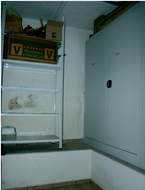
Abbildung 7-37 Verfärbungen am Putz zeigen die Feuchtebeanspruchung an.
