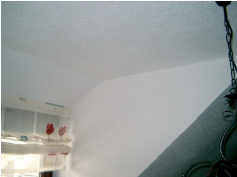
Abbildung 7-66 Abkühlung am Übergang zum Deckenbereich, Ursache: nicht anliegende Zellulose-Wärmedämmung, Temperaturunterschied ca. 6,5 Kelvin
