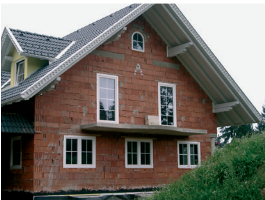
Abbildung 6-5 Typischer Vertreter einer möglichen schadensträchtigen Wärmebrücke: auskragende Stahlbetondecke eines Balkons, hier nicht fachgerecht ohne thermische Entkopplung ausgeführt
