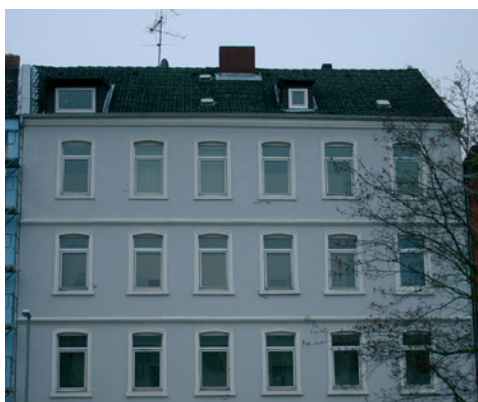
Abbildung 8-2 Altbau mit deutlicher Abzeichnung der Lage der Heizkörper (hier: Elektro-Nachtspeicherheizkörper)
