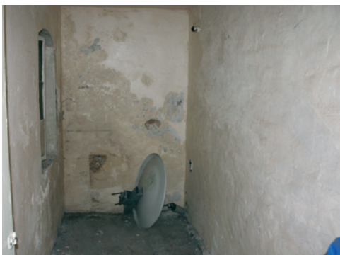
Abbildung 7-36 Durchfeuchtete Bereiche einer Kelleraußenwand, der Verlauf des Durchfeuchtungshorizontes ist bereits visuell wahrnehmbar.
