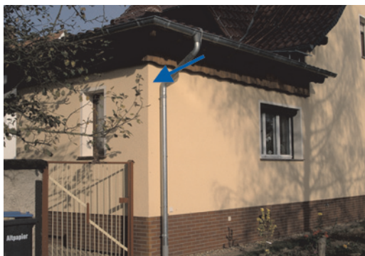
Abbildung 6-6 Schadenfreier Außenwandeckbereich eines mit WDV-System gedämmten Gebäudes (Dämmstoffdicke 10 cm, WLK 040)
