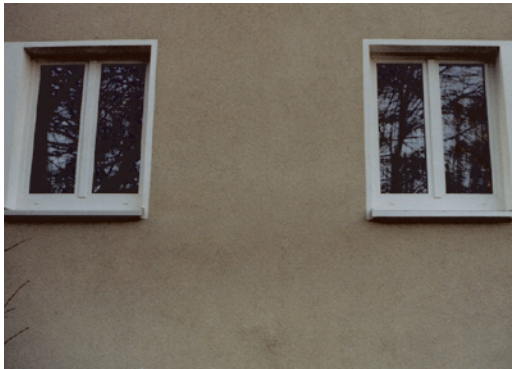
Abbildung 7-62 Detail aus Abbildung 6-56 mit der sich im WDVS zwischen den Fenstern abzeichnenden erhöhten Oberflächentemperatur (Messwert: \theta_{se} = 4,4 \text{ °C} )
