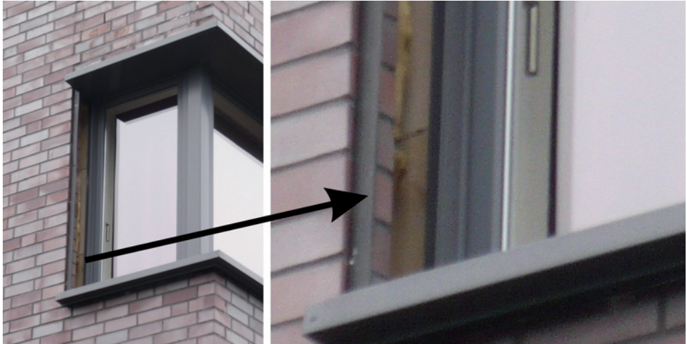
Abbildung 7-71 Öffnung der außenliegenden Verblechung, mit Vergrößerung: Die Wärmedämmung war nicht vollflächig im Bereich der Laibung verlegt.
