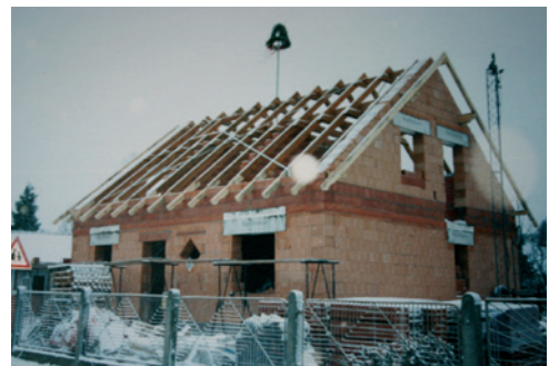
Abbildung 7-11 Wohnhaus zum Zeitpunkt der Thermografie und während der Bauphase, oberhalb der Fenster befindet sich der gedämmte Rollladenkasten und der umlaufende Ringbalken (U-Schalen mit Stahlbeton)
