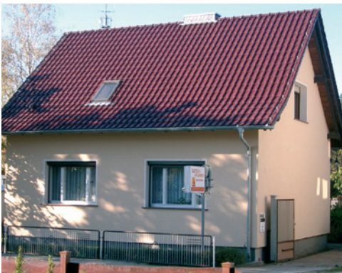
Abbildung 7-59 Aufnahme nach Durchführung von Wärmedämm-Maßnahmen am Dach (20 cm, WLG 045) und an den Außenwänden (10 cm, WLG 040), Sockelbereich noch nicht gedämmt (Stand: November 2004)
