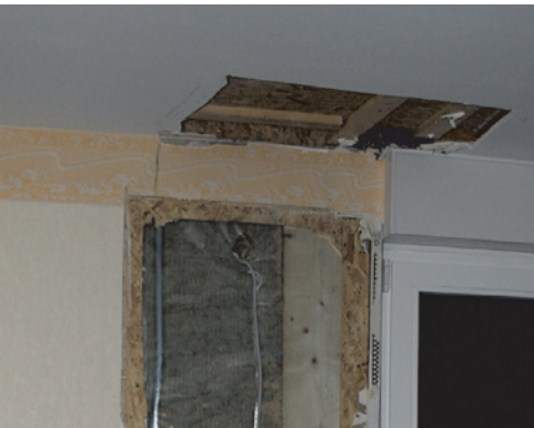
Abbildung 7-32 Geöffneter Wand-Deckenbereich und Thermogramme vor und nach Aufbringung eines Unterdrucks (ca. 50 Pa)
