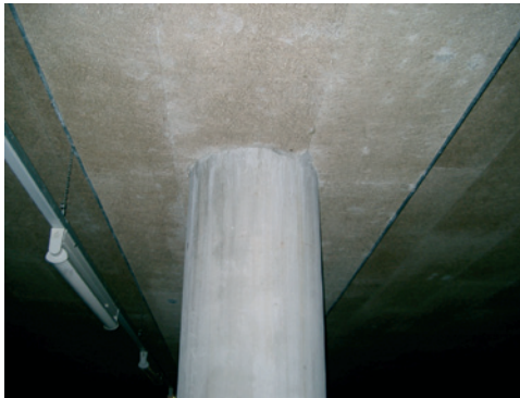
Abbildung 7-10 Durch die Wärmedämmebene durchgeführte Betonstütze
