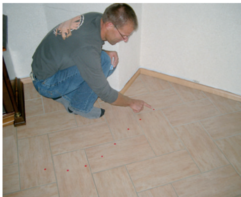
Abbildung 7-42 Heizleitungen zeichnen sich auf dem Parkettfußboden ab. Die Lage der Heizleitungen wird mit Hilfe von Klebepunkten dokumentiert.
