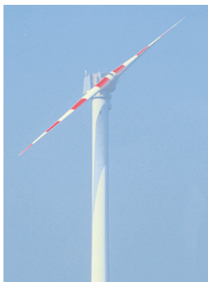
■ Abb. 41: Zweiblattrotor Aeolus II (MBB), 3 MW Nennleistung, 80 m Rotordurchmesser
