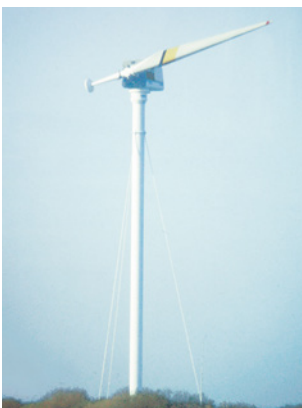
■ Abb. 40: Einblatt-Turbine Monopteros (MBB), 640 kW Nennleistung, 56 m Rotordurchmesser
