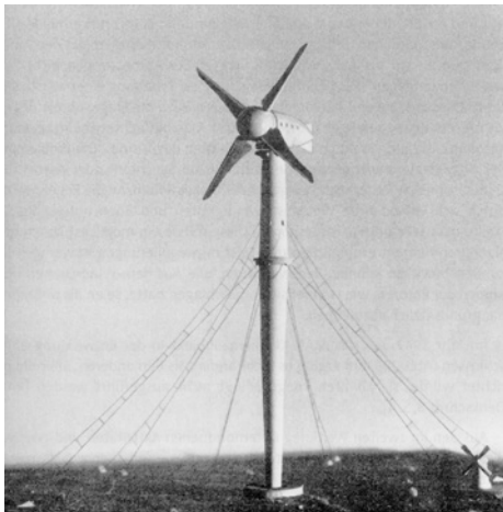
Abb. 22: MAN-Kleinhenz-Windkraftwerk (1942), 130 m Rotordurchmesser 10 MW Nennleistung
