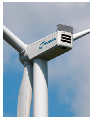
■ Abb. 42: Dreiblattanlage Nordex 117, 2400–3000 kW Nennleistung, 117 m Rotordurchmesser
