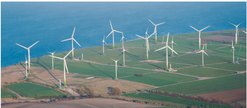
■ Abb. 82: Auf Fehmarn (Schleswig Holstein) wurde 2006–2007 das lange Zeit größte deutsche Repoweringprojekt durchgeführt. Das Bild zeigt, wie alte Enercon E 40 Schritt für Schritt gegen neue E 70 ausgetauscht werden. Die neuen Anlagen mussten wegen der damals noch gültigen Höhenbegrenzung auf Türmen montiert werden, die auf 64 m verkürzt waren.
