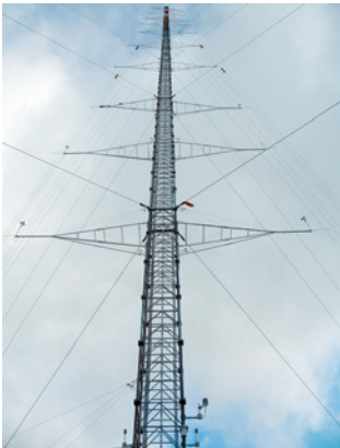
■ Abb. 78: 200 m hoher Messmast des Fraunhofer IWES für detaillierte Untersuchungen der Windbedingungen im bewaldeten Mittelgebirge
