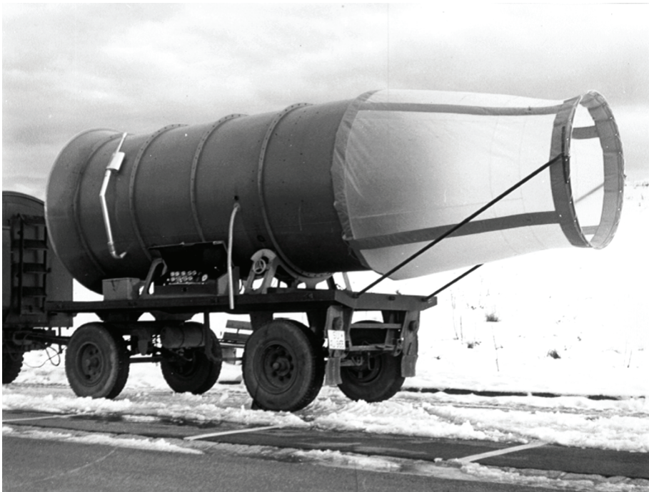
Abb. 2: Der neue Entnebelungsapparat von Ulrich Schmieschek 1968. Quellenangabe: DLR. KPAR A495: K. Wanders, Studie über das DVL-Entnebelungsverfahren nach U. Schmieschek. Deutsche Versuchsanstalt für Luft- und Raumfahrt, Januar 1968, S. 7.
