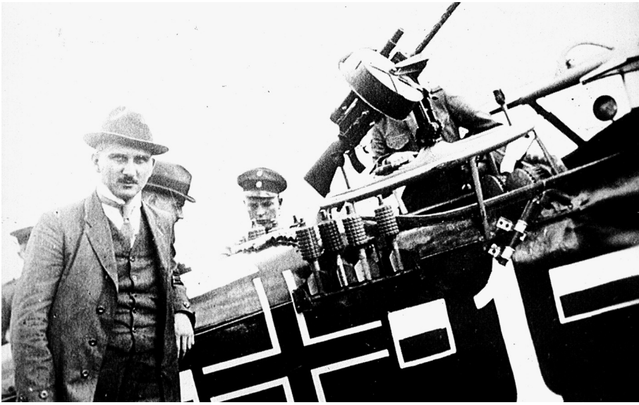
Abb. 4: Der Konstrukteur der Halberstadt-Schlachtflugzeuge, Karl Theis, besucht am 10. August 1918 eine Schlachtstaffel. Gut zu erkennen die Wurfgranaten, die Signalpistole, das Schützenmaschinengewehr, und im Hintergrund der Rückspiegel des Piloten. Quelle: Peter M. Grosz, Halberstadt CI.IV (Windsock Datafile, Bd. 43), Berkhamsted 1994, S. 7.
