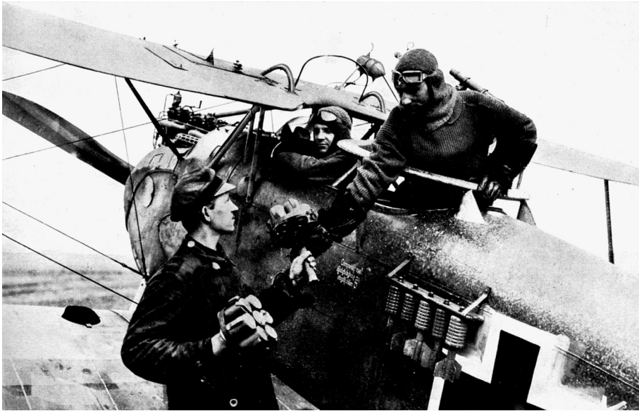
Abb. 5: Munitionierung des Waffensystems: ‚Geballte Ladungen‘ werden an Bord genommen. Seitlich hängen ‚Wurfgranaten 1916‘. Die Besatzung trägt Sportkleidung als Fliegersonderbekleidung. Quelle: Peter Supf, Das Buch der deutschen Fluggeschichte, Bd. 2: Vorkriegszeit, Kriegszeit, Nachkriegszeit bis 1932, Stuttgart 1958, S. 309.
