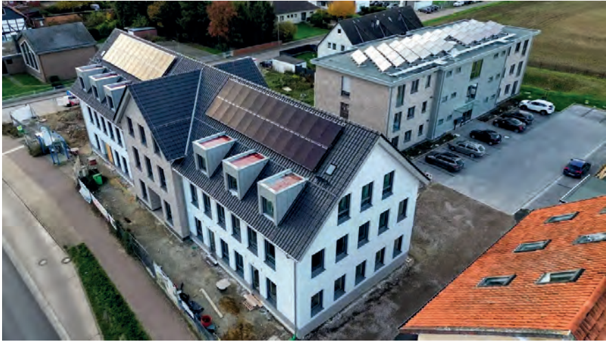
Wirtschaftlichkeit sowie Umwelt- und Klimaschutz spielen eine wichtige Rolle bei den Bauprojekten der kwg. Im Bild ein neues Mehrfamilienhaus in Schellerten (Foto: kwg)
