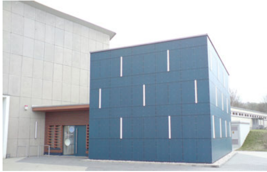
Abbildung 2: Die Außenansicht der CAVE der TU Dresden.
