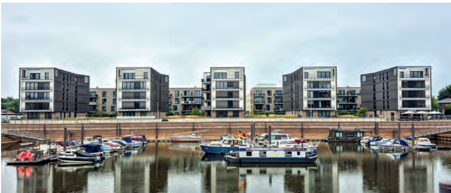
Abb. 5: Umsetzung Allerinsel 1. Bauabschnitt (Foto: U. Kinder)
