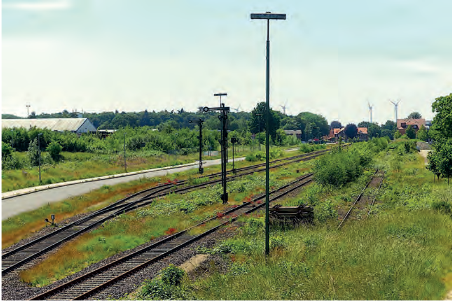
Abb. 6: Das Mittelzentrum Sulingen ist zwar ein Bahnknoten, wird jedoch seit Jahrzehnten nur noch vereinzelt im Güterverkehr genutzt. Der Reisezugverkehr wurde im Jahr 1994 eingestellt (Foto: Axel Priebs)
