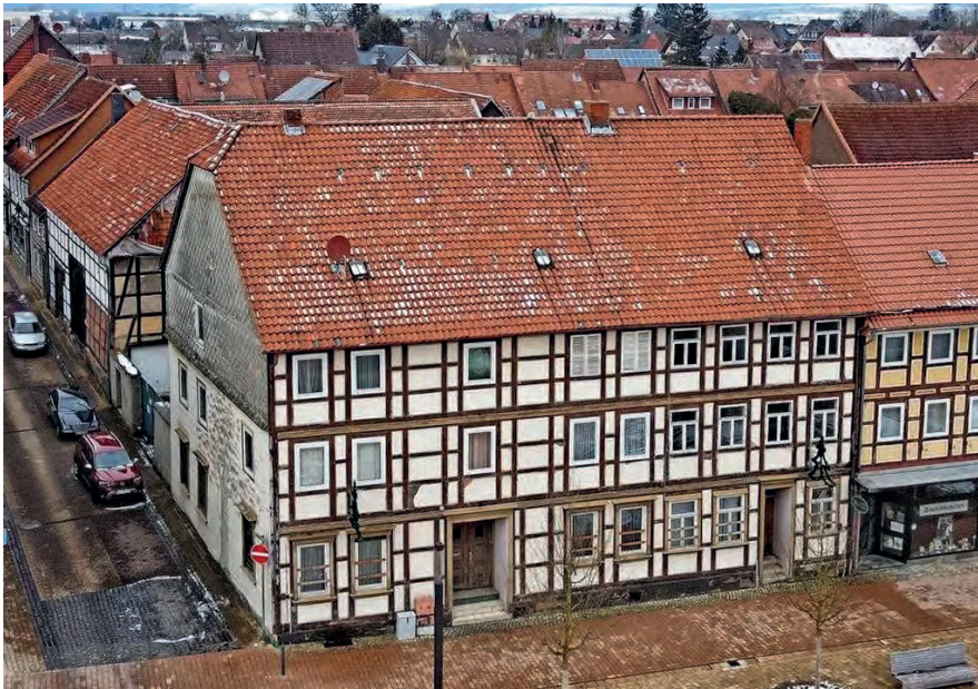
Neues Argentum in Bockenem: In dem alten Gebäude am Bockenemer Buchholzmarkt plant die kwg neun Wohnungen für ältere Menschen und Personen mit Einschränkung (Foto: kwg)
