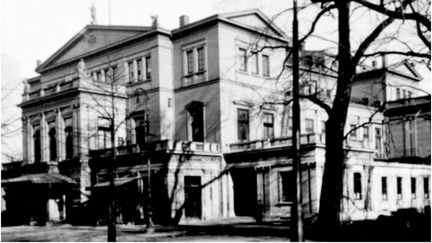
Ehemaliges Stadttheater am Wall. (Foto: Focke Wortmann)
