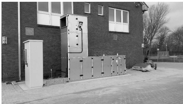
Bild 4: Absaugung Rechenanlagen und gekapselte Klärbecken auf Kläranlage, 6.000m 3 /h, Deutschland
