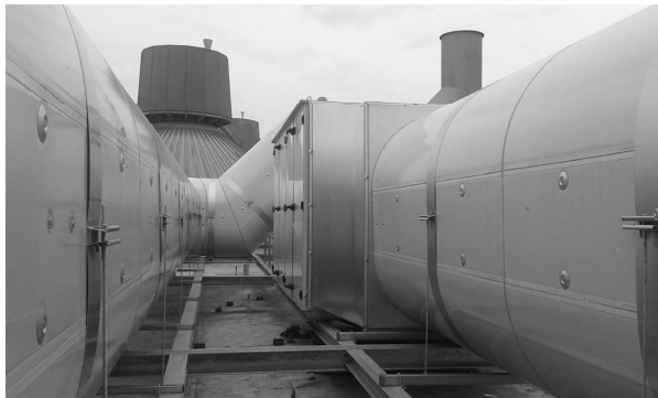
Bild 1: Abfallbehandlung zur Ersatzbrennstoffgewinnung in Zementwerk 45.000m 3 /h, Deutschland
