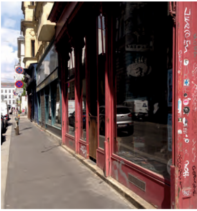
Abb. 3 Das sog. Portal ist eine Holz-Glas-Konstruktion, die der EG-Fassade vorgestellt wird und eine Zone des Übergangs bildet. © Penner 2018
