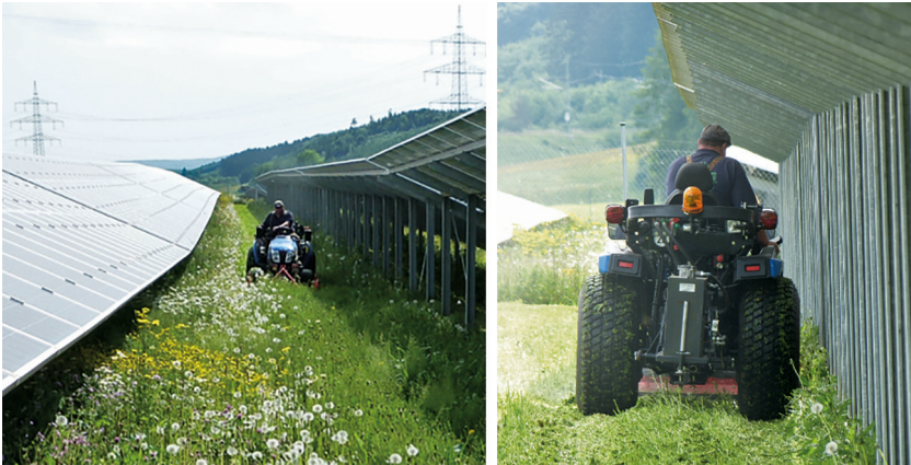
Abbildung A3: Mulcharbeiten in der Freiflächen Fotovoltaikanlage in Döggingen Ende Mai 2022
