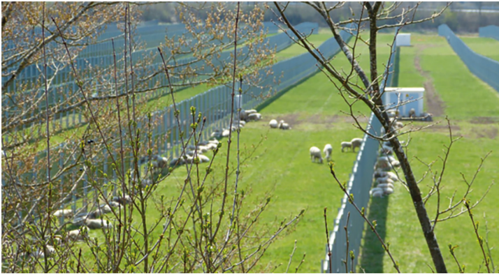
Abbildung 1: Beispiel einer Agri-Fotovoltaikanlage, die eine „reguläre“ ackerbauliche Nutzung auf der Fläche erlaubt. Kommerzielle Anlage mit senkrecht stehenden bifazialen Modulen in Donaueschingen-Aasen (Foto Müller-Sämann).
