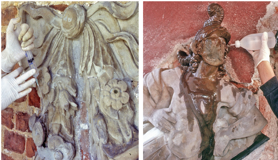
Bild 10.14 Aufbringen eines Hydrophobierungsmittels durch Fluten. Mittels Spritze und Kanüle (links); mit einer Spritzflasche (rechts). (Fotos: © Katarina Malaga, Mölndal, Schweden)
