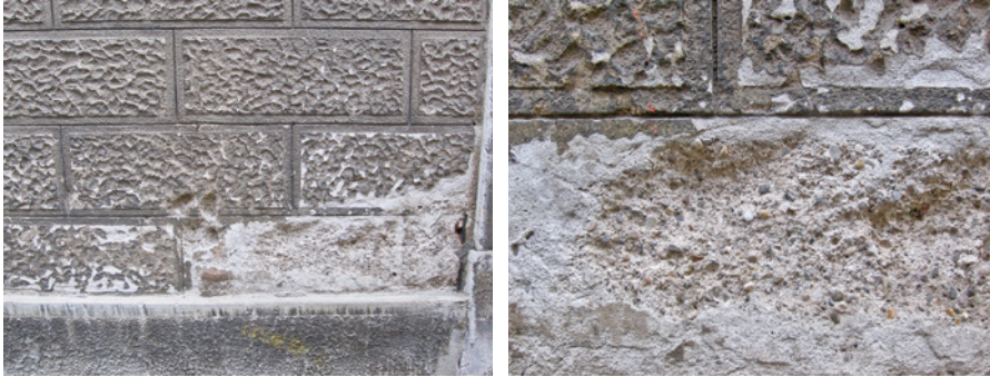
Bild 3.24 Imitation einer Natursteinfassade in Ljubljana, Slowenien (links). Die Putzdekoration aus Romanzementmörtel wurde mit einer Silikatfarbe versehen, um einen gräulichen Kalkstein zu imitieren.
