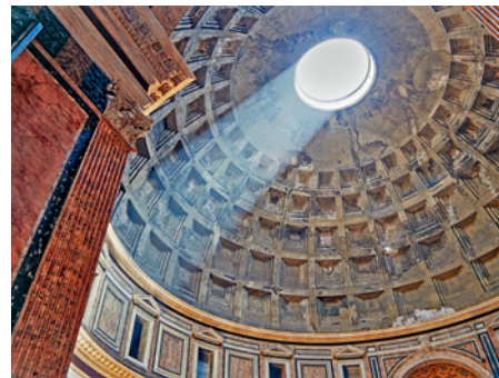
Bild 4.5 Caracalla Thermen in Rom: Wände und Kuppel sind aus römischem Beton, der mit einer dünnen Ziegelschale verkleidet und mit einem Kalkstuck dekoriert war (links). Kuppel des Pantheons in Rom. Verwendet wurde ein Leichtbeton mit variierender Dichte (rechts).
