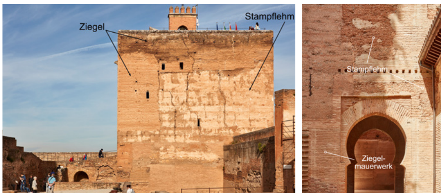
Bild 5.2 Stampflehm-Bauweise in der Alhambra, Granada. Teile der Bauteile wurden mit Ziegeln verstärkt bzw. ausgebessert.
