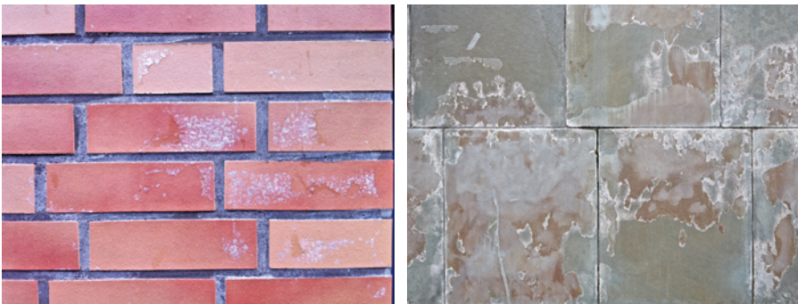
Bild 10.23 Feuchteschäden in Form von Blasen und Abblätterungen an einer dampfdichten Anti-Graffiti-Beschichtung auf einer Klinkeroberfläche (links) und an einer dichten AGS 1-1-Beschichtung auf einem Naturstein (rechts).
