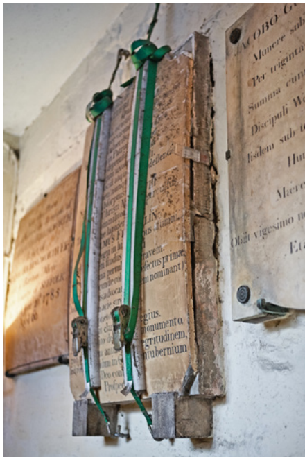
Bild 9.20 Marmorplatten, die durch Temperatur- und Feuchtwechsel gewölbt sind; hier eine Marmorgrabplatte der Westminster Kirche in London.
