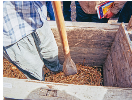
Bild 5.5 Arbeitsschritte beim Stampfen von Lehm: Schalung aufbauen, mit Lehm befüllen und verdichten, Schalung abbauen und um eine Stoßlänge versetzen.
