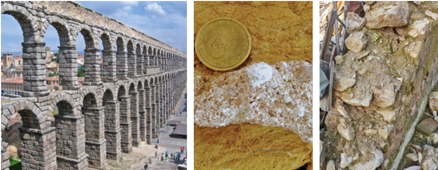
Bild 2.2 Beispiele für verschiedene Mauerwerksverbände (von links nach rechts): ohne Mörtel (Aquädukt, Segovia, Spanien), Natursteinmauerwerk mit Kalkmörtel und Bruchsteinmauerwerk mit Lehm Mörtel.
