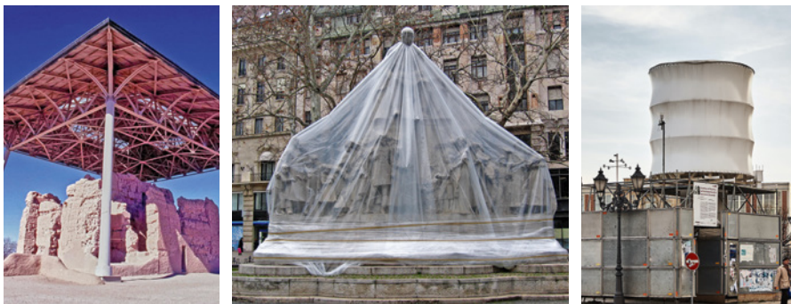
Bild 10.1 Schutzüberdachung von archäologischen Bauwerksresten (links) sowie temporäre Wintereinhausung eines Brunnens (Mitte) und einer Skulptureneinhausung (rechts).
