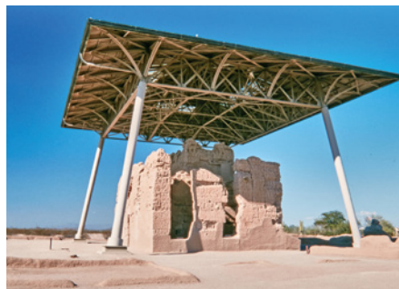
Bild 5.10 Links: Ein Schwitzbad in Wellerlehm, gebaut von den Maya ca. 500 n. Chr. (Joya de Ceren, El Salvador). Rechts: Ein ursprünglich vierstöckiges Gebäude in wellerlehmähnlicher Bausweise (Casa Grande), errichtet von den Hohokam in Zentralarizona nahe dem heutigen Phoenix, U.S.A. Die Schutzüberdachung wurde Anfang des 20. Jahrhunderts gebaut und steht heute selbst unter Denkmalschutz.
