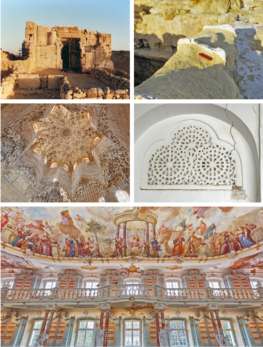
Bild 3.15 Amuntempel des Orakels von Siwa, Ägypten (obere Reihe). Das Mauerwerk besteht aus zwei Schalen, das mit Gipsmörtel ausgegossen wurde. Stalaktitengewölbe aus Gips in der Alhambra, Granada, Spanien (Mitte links). Gips Schnitzereien am Amiri-Palast in Doha, Katar (Mitte rechts). Stuckgipsdekorationen im Bibliothekssaal des barocken Klosters Schussenried in Oberschwaben (unten).
