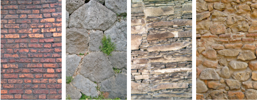
Bild 2.1 Beispiele für Mauerwerk (von links nach rechts): regelmäßiges Ziegelmauerwerk, Zyklopenmauerwerk, Bruchsteinmauerwerk, Feldsteinmauerwerk.
