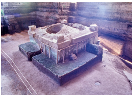
Bild 5.10 Links: Ein Schwitzbad in Wellerlehm, gebaut von den Maya ca. 500 n. Chr. (Joya de Ceren, El Salvador). Rechts: Ein ursprünglich vierstöckiges Gebäude in wellerlehmähnlicher Bausweise (Casa Grande), errichtet von den Hohokam in Zentralarizona nahe dem heutigen Phoenix, U.S.A. Die Schutzüberdachung wurde Anfang des 20. Jahrhunderts gebaut und steht heute selbst unter Denkmalschutz.
