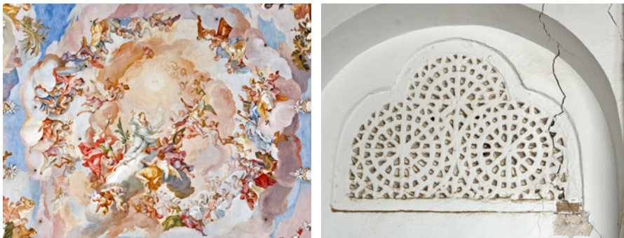
Bild 2.3 Putzdekorationen in Form eines Deckenfreskos in einem Kalkputz (Wallfahrtskirche Steinhausen, links) und in Form von Schnitzereien in einem Gipsputz (historischer Amiri-Palast in Doha, rechts).
