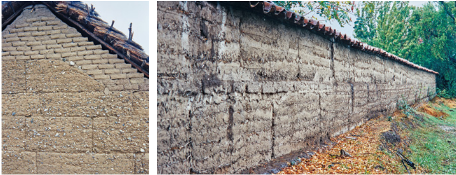
Bild 5.6 Stampflehmwände mit starker Schwindverformung. Durch die Schwindfugen werden die einzelnen Stöße der Schalung deutlich sichtbar. Im linken Bild wurde der Giebelbereich mit Lehmsteinen aufgemauert. Im rechten Bild sind deutlich Lagen von Strohhäcksel zu erkennen, die ein Überspringen der Schwindfugen in den darüber liegenden Stoß verhindern sollten. Sichtbar ist auch, dass die Stöße versetzt sind (Putando, Chile).
