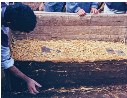
Bild 5.5 Arbeitsschritte beim Stampfen von Lehm: Schalung aufbauen, mit Lehm befüllen und verdichten, Schalung abbauen und um eine Stoßlänge versetzen.
