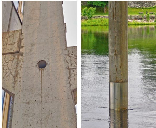
Bild 9.27 Alkali-Kieselsäure Reaktion in einer Betonstütze eines Gebäudes (links) und in einem Brückens Pfeiler (rechts). Deutlich sind ausgeprägte Rissbildungen zu erkennen.
