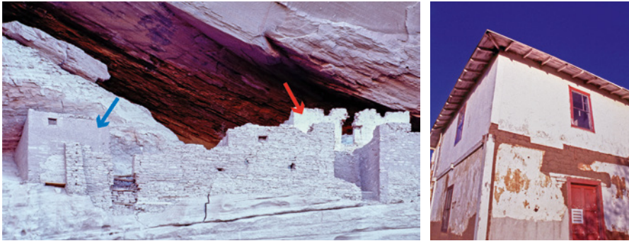
Bild 3.26 Historische Lehmputze und Lehmputze. White House Ruins, Canyon de Chelly, Arizona, U.S.A (links). Der blaue Pfeil zeigt Lehmputz, der rote Pfeil Lehmputz mit Kalkschlämme. Das Natursteinmauerwerk wurde mit Lehmmauermörtel hergestellt. Rancho Las Flores, Südkalifornien, U.S.A (rechts); Lehmsteinmauerwerk, gemauert und verputzt mit Lehmputz. Auf den Lehmputz wurde ein dünner Kalkputz aufgebracht.
