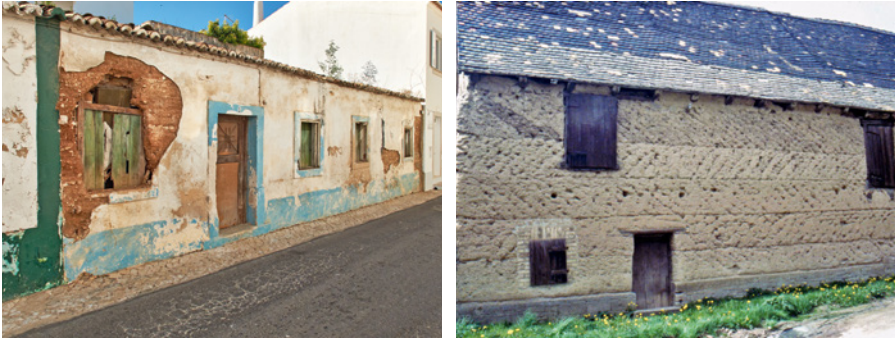
Bild 5.1 Historisches Stampflehmhaus, Albufeira, Portugal (links). Scheune in Wellerlehm, Albersroda, Sachsen-Anhalt (rechts; Foto: © Christof Ziegert, ZRS Architekten Ingenieure, Berlin).
