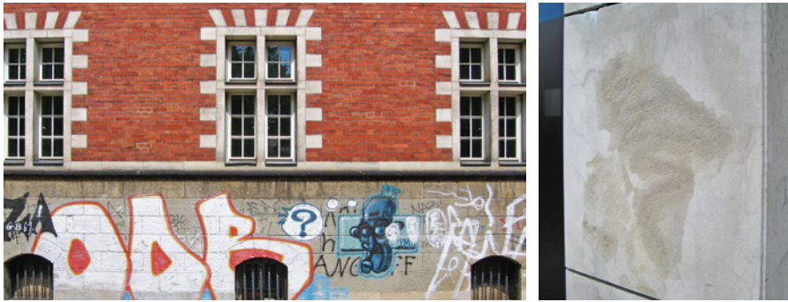
Bild 10.17 Graffiti, die mit verschiedenen Farbmitteln auf eine Hauswand aufgebracht wurden (links). Unsachgemäß gereinigte Fassadenplatte: Das ursprüngliche Graffiti wurde zwar entfernt, mit diesem aber auch die oberste Schicht des Sandsteins (rechts).
