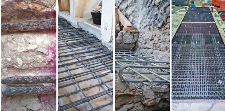
Bild 4.4 Verschiedene Arten der Bewehrung in Beton. Von links nach rechts: Glatte Stahlstäbe, gerippte Stahlstäbe, GFK-Bewehrung mit Gewindegängen, Textilbewehrung bestehend aus einem Carbonfasernetz, das in Epoxidharz getränkt wurde (mittlere zwei Bilder: © ZRS Architekten Ingenieure, Berlin)
