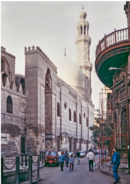
Bild 9.15 Feuchtefront in einer Mauer der Altstadt von Kairo (linke Bildseite). Die dunklen Bereiche sind salzgesättigt und nehmen aus der Umgebungsluft große Mengen an Feuchtigkeit auf.
