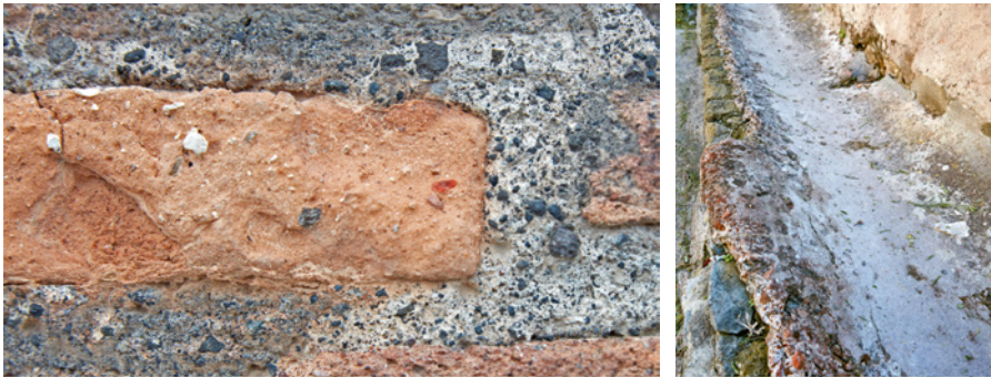
Bild 3.8 Römisches Ziegelmauerwerk mit hydraulischem Kalkmörtel und Puzzolanerde von Pozzuoli als Mörtelzusatz (links; Pompei bei Neapel, Italien). Römischer Wasserzulauf aus Mauerwerk mit einer Auskleidung aus hydraulischem Kalk (rechts; Herculaneum bei Neapel, Italien).
