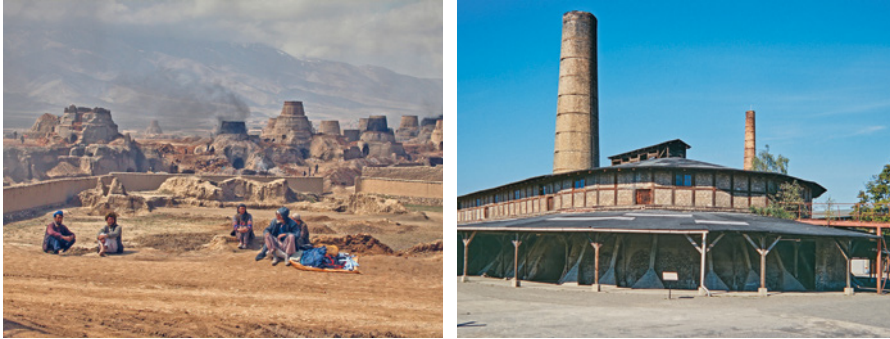
Bild 2.34 Herstellung von Ziegelprodukten: Brennen in Feldbrandöfen in der Nähe von Kabul, Afghanistan (Foto: © Hartmut Pliett, Karlsruhe) und Hoffmannscher Ringofen (rechts, Ziegelpark Mildenberg bei Berlin).
