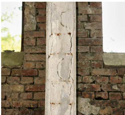
Bild 9.24 Bewehrungskorrosion an einem Tragrahmen aus Beton.
