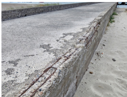
Bild 9.26 Chloridinduzierte Bewehrungskorrosion in einem Beton einer Anlage am Meer. (Foto: © Katarina Malaga, Mölndal, Schweden)
