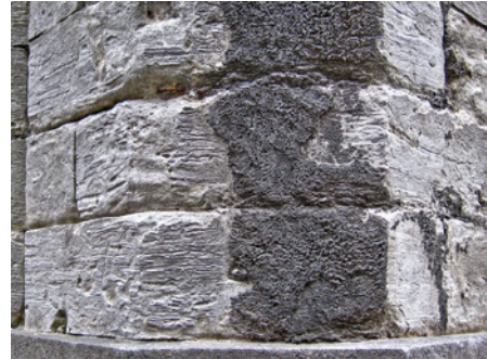
Bild 9.19 Gipskruste (dunkelgrau) auf dem Kalksteinmauerwerk (hellgrau) einer Kirche, die im städtischen Milieu Schwefeldioxidemissionen ausgesetzt war (Ste-Catherine, Brüssel).
