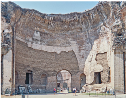
Bild 4.5 Caracalla Thermen in Rom: Wände und Kuppel sind aus römischem Beton, der mit einer dünnen Ziegelschale verkleidet und mit einem Kalkstuck dekoriert war (links). Kuppel des Pantheons in Rom. Verwendet wurde ein Leichtbeton mit variierender Dichte (rechts).
