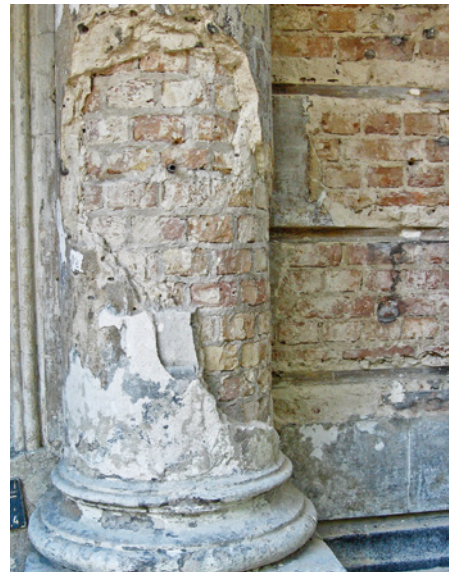
Bild 3.23 Ziegelmauerwerk an einem Berliner Gründerzeithaus, welches mit einem dekorativen Romanzementputz versehen wurde, um eine Natursteinfassade nachzuahmen.
