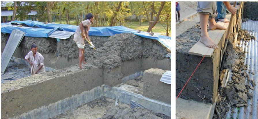
Bild 5.11 Vorgehensweise bei der Bauweise mit Wellerlehm (Fotos: © Christof Ziegert, ZRS Architekten Ingenieure, Berlin)
