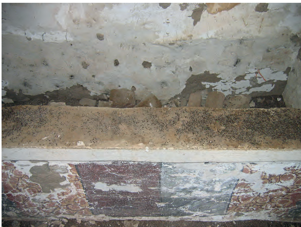
Abb. 24: Erdgeschoss, 2. Raum, Detail Nordwand; 2005
