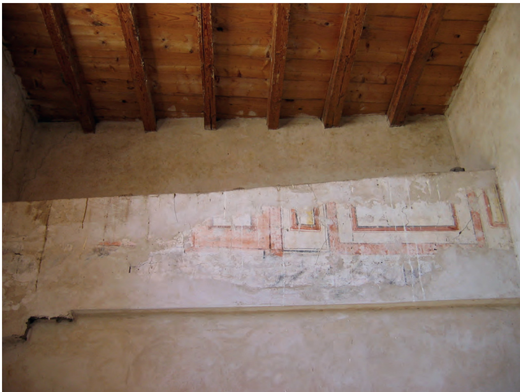
Abb. 17: Obergeschoss, 1. Raum, Westwand; 2005
