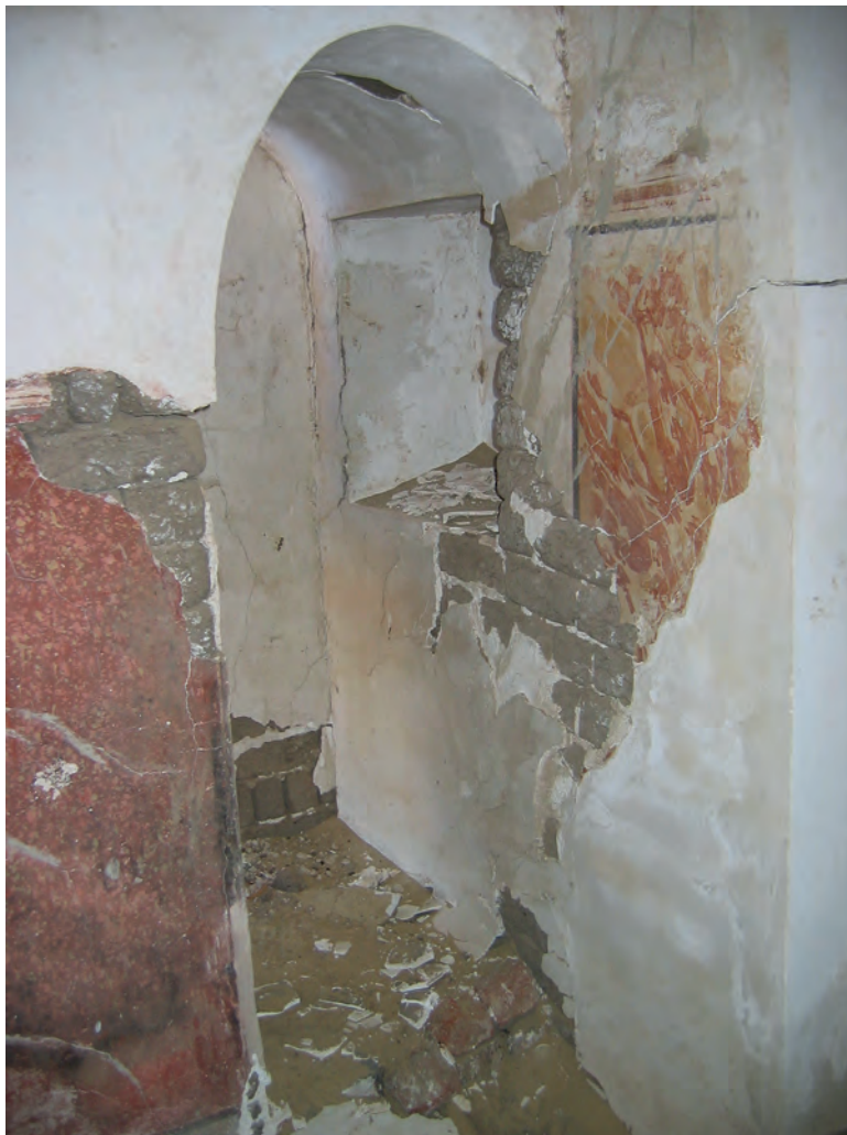
Abb. 11: Obergeschoss, 1. Raum, Ostwand, Seitenkammer; 2006
