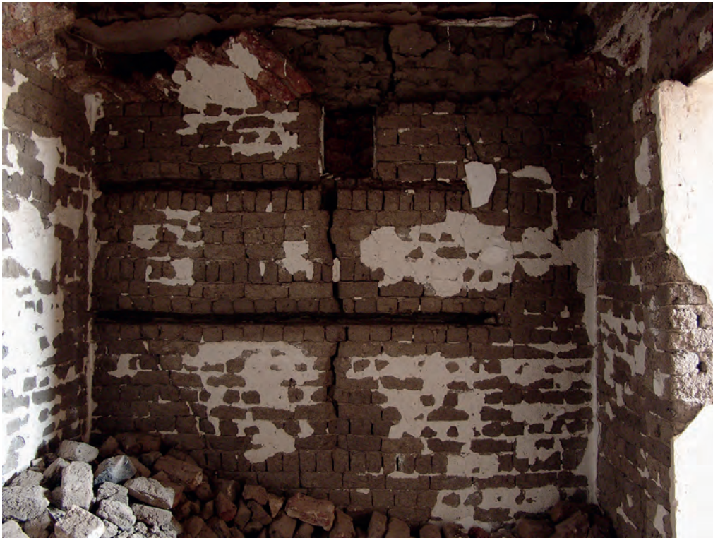
Abb. 26: Raum GB 7.2.3, Holzbewehrung in der Nordwand; 2006
