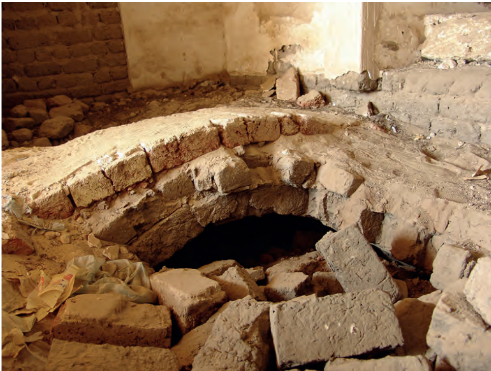
Abb. 8: Gewölbeausbruch im Fußboden in Raum GB 6.2.3; 2006
