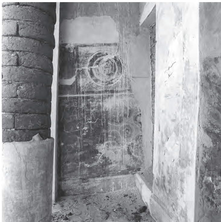
Abb. 41: Südwand der Vorhalle GB 7.2.1; 1987
