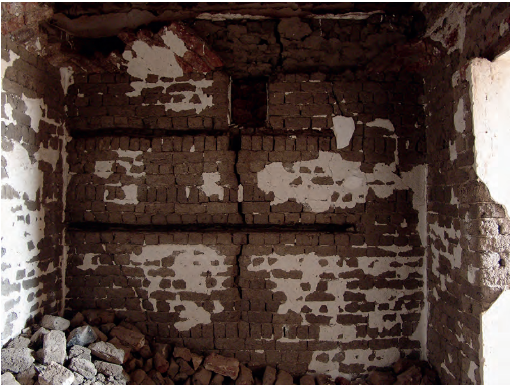
Abb. 26: Raum GB 7.2.3, Holzbewehrung in der Nordwand; 2006
