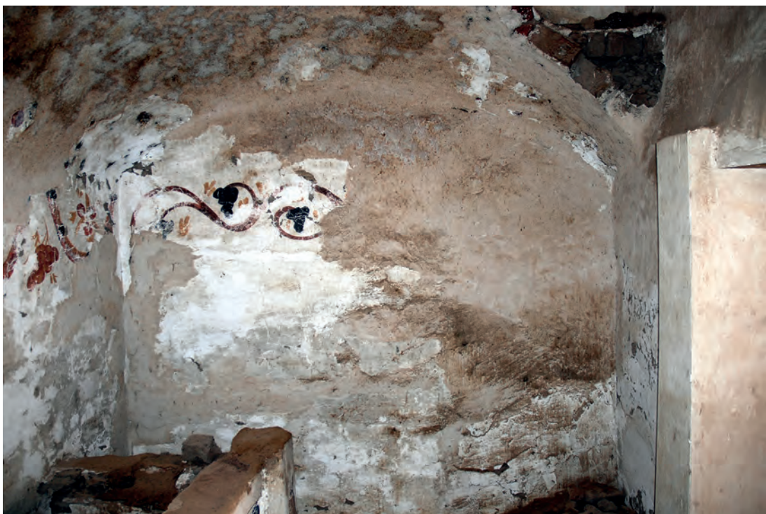
Abb. 14: Erdgeschoss, 2. Raum, Ostwand; 2008
