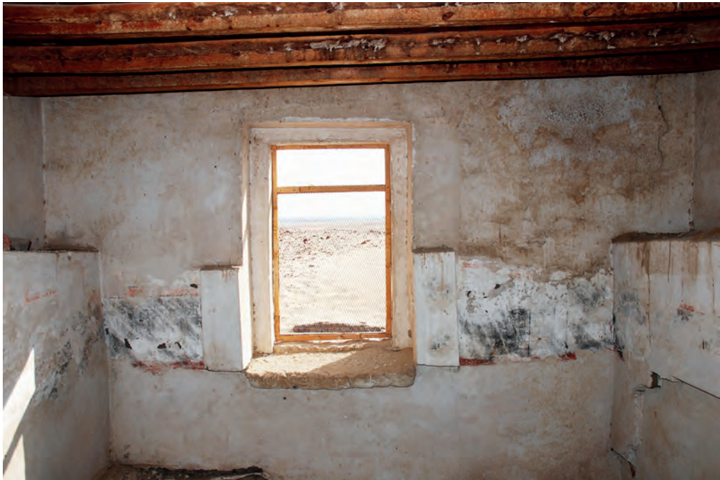
Abb. 16: Obergeschoss, 1. Raum, Südwand; 2008
