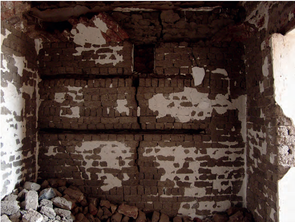
Abb. 26: Raum GB 7.2.3, Holzbewehrung in der Nordwand; 2006
