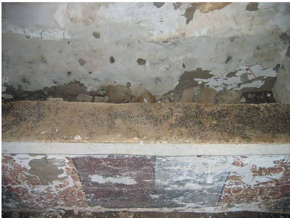
Abb. 24: Erdgeschoss, 2. Raum, Detail Nordwand; 2005
