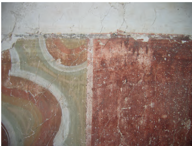
Abb. 8: Vorraum, Nordwand, Detail; 2007
