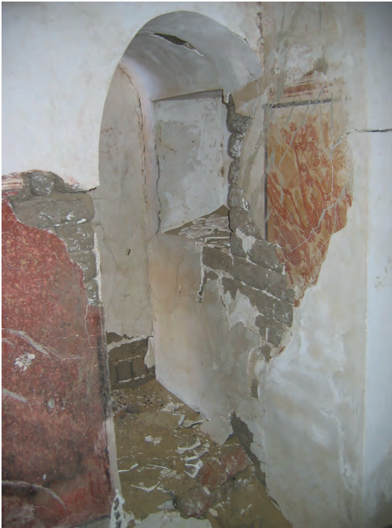
Abb. 11: Obergeschoss, 1. Raum, Ostwand, Seitenkammer; 2006
