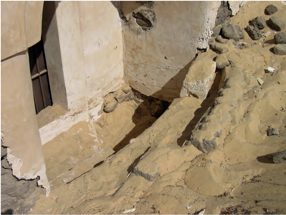
Abb. 15: Erdgeschoss, Eingang von Westen; 2006
