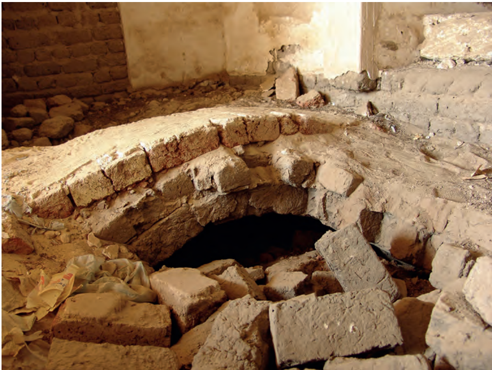
Abb. 8: Gewölbeausbruch im Fußboden in Raum GB 6.2.3; 2006
