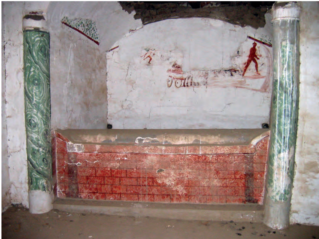
Abb. 3: Obergeschoss, 2. Raum, Südwand mit Alkoven; 2006
