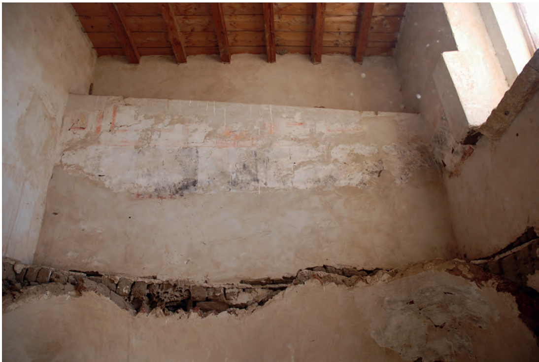
Abb. 4: Obergeschoss, 1. Raum, Ostwand; 2008
