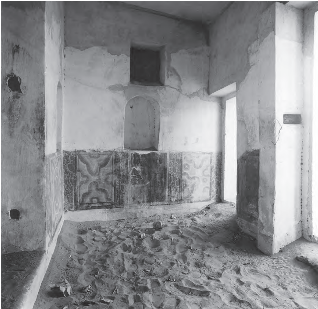
Abb. 18: Nordseite von Raum GB 6.2.2; 1987
