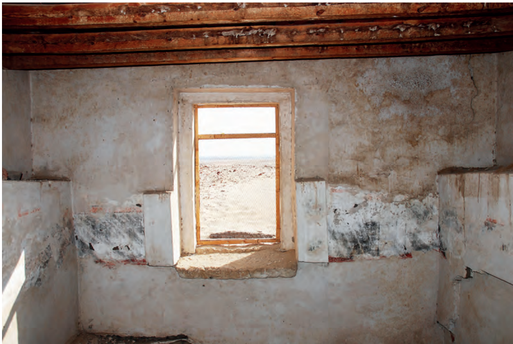
Abb. 16: Obergeschoss, 1. Raum, Südwand; 2008
