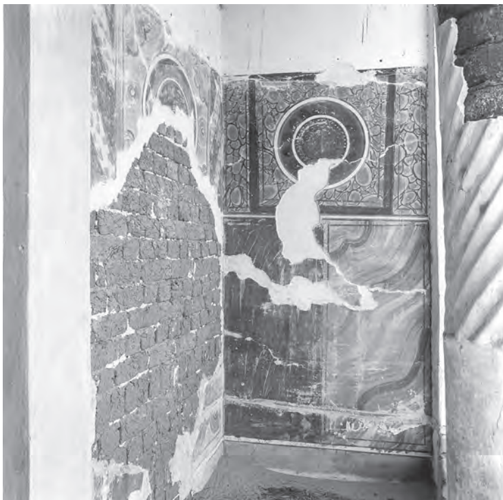
Abb. 40: Nordwand der Vorhalle GB 7.2.1; 1987
