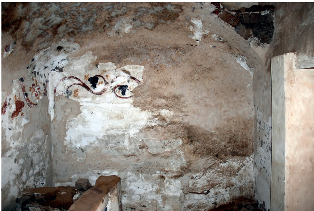
Abb. 14: Erdgeschoss, 2. Raum, Ostwand; 2008
