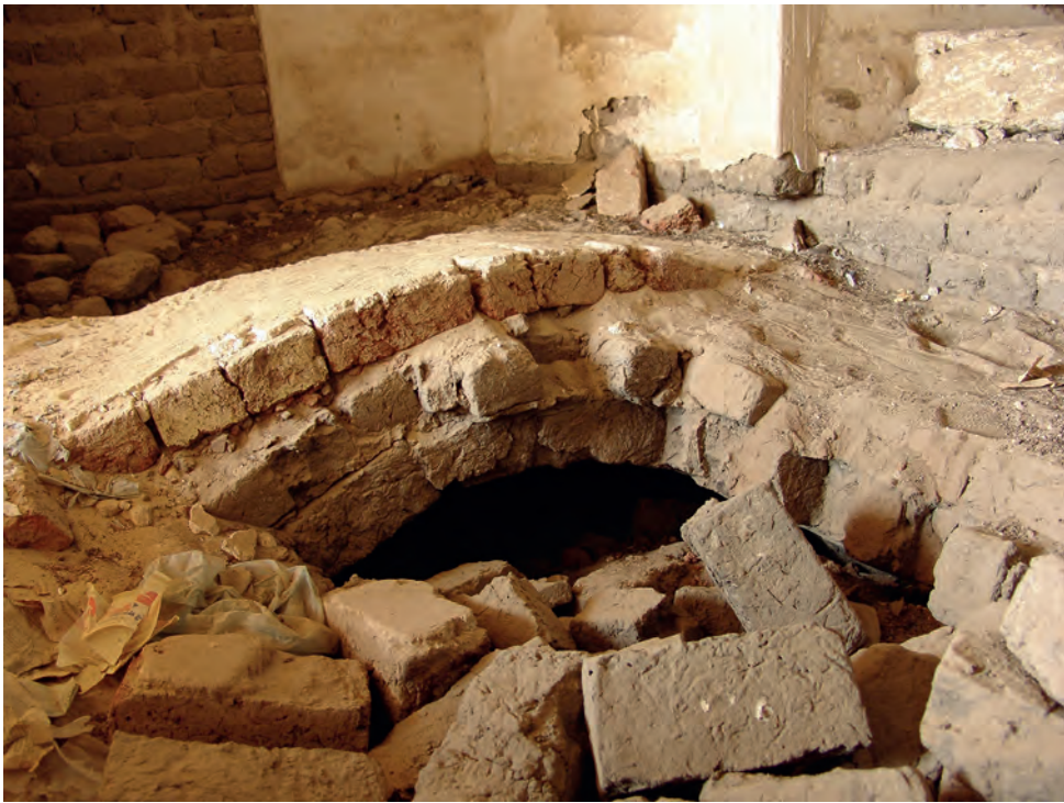
Abb. 8: Gewölbeausbruch im Fußboden in Raum GB 6.2.3; 2006
