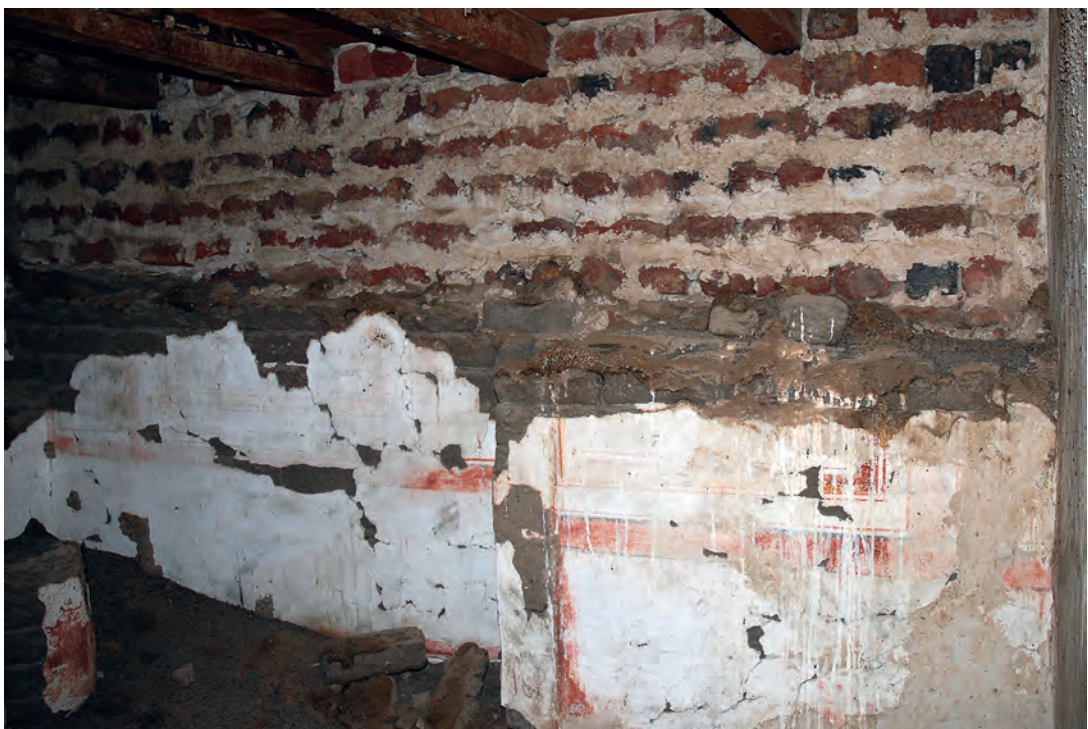
Abb. 20: Obergeschoss, 2. Raum, Ostwand; 2008
