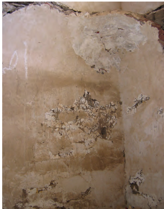
Abb. 11: Erdgeschoss, 1. Raum, Südostecke; 2005
