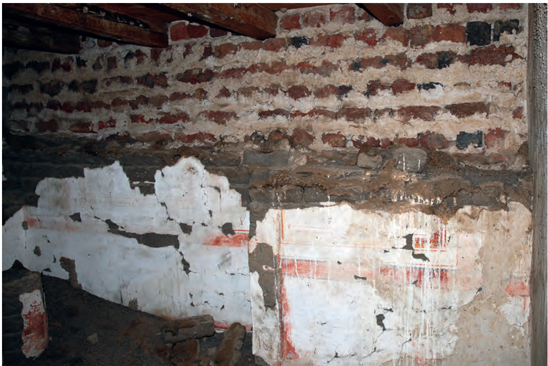
Abb. 20: Obergeschoss, 2. Raum, Ostwand; 2008
