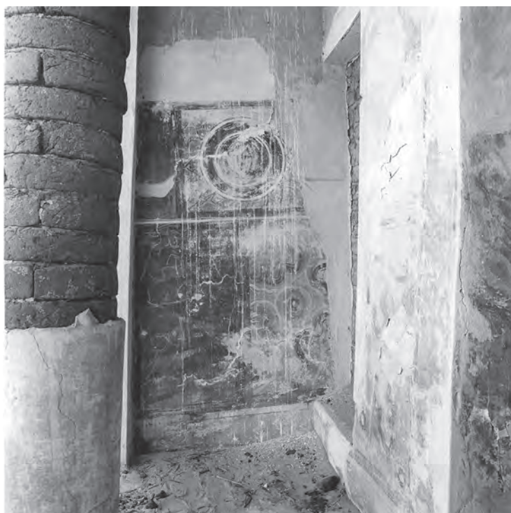
Abb. 41: Südwand der Vorhalle GB 7.2.1; 1987
