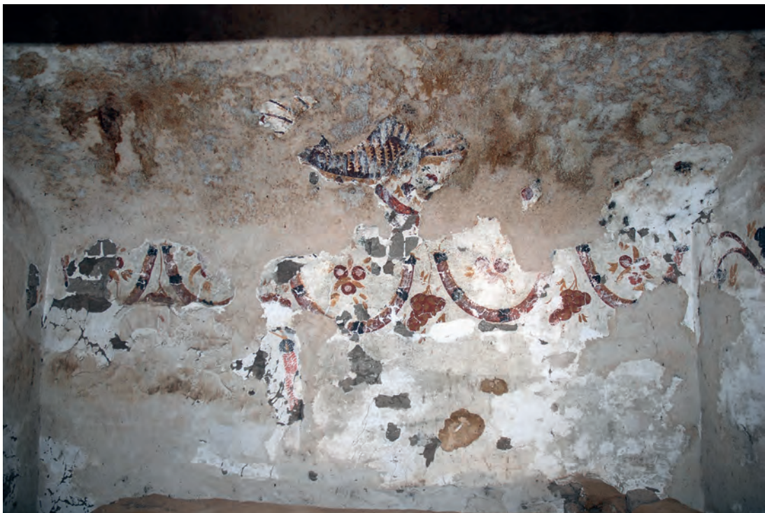
Abb. 5: Erdgeschoss, 2. Raum, Nordwand; 2008
