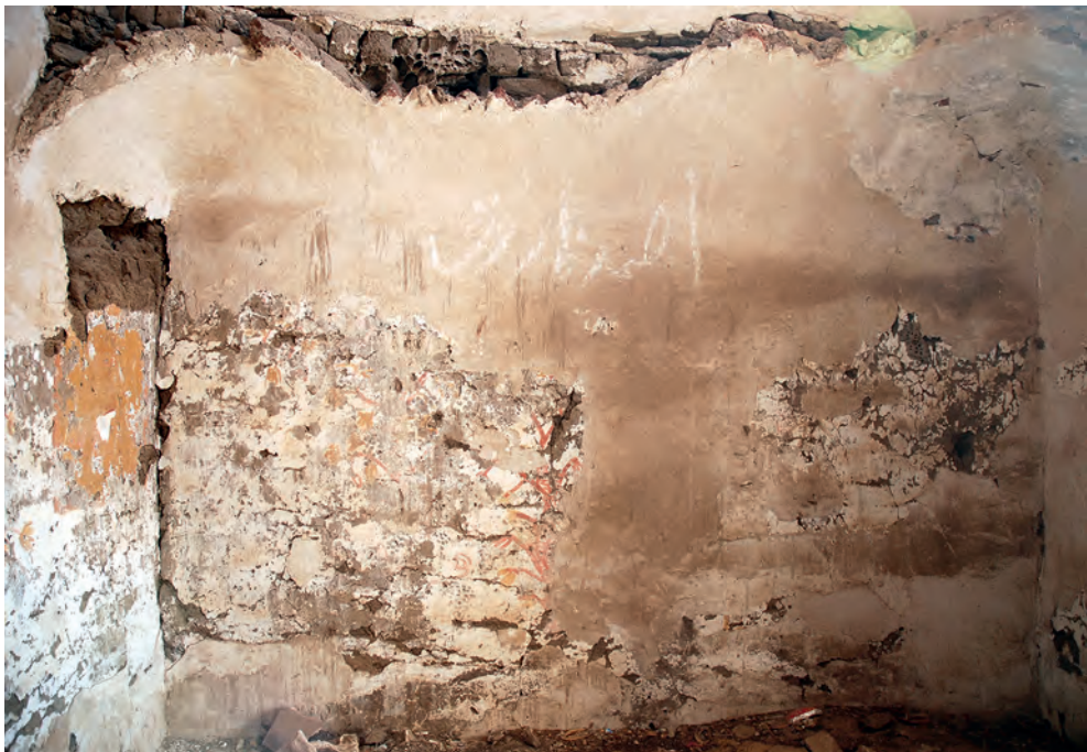
Abb. 8: Erdgeschoss, 1. Raum, Ostwand; 2005
