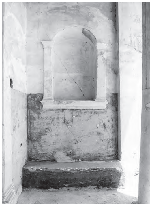
Abb. 4: Vorhalle, Nische in Ostwand; 1987
