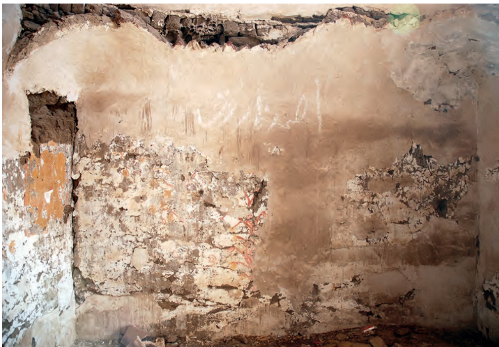
Abb. 8: Erdgeschoss, 1. Raum, Ostwand; 2005
