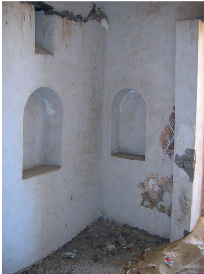
Abb. 20: Blick in die Nordostecke von Raum GB 7.2.2; 2005
