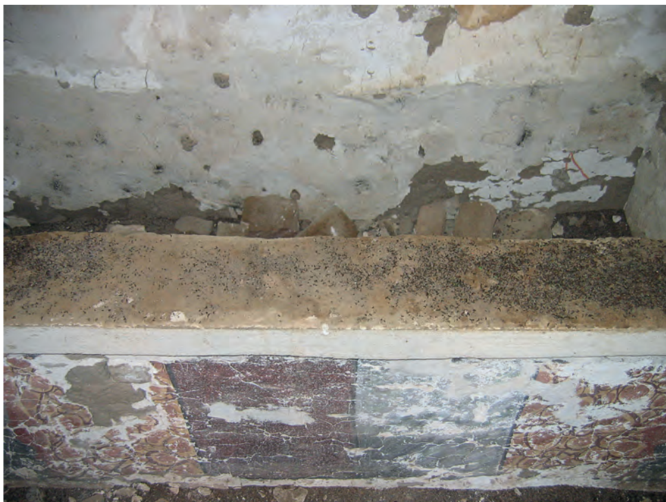
Abb. 24: Erdgeschoss, 2. Raum, Detail Nordwand; 2005
