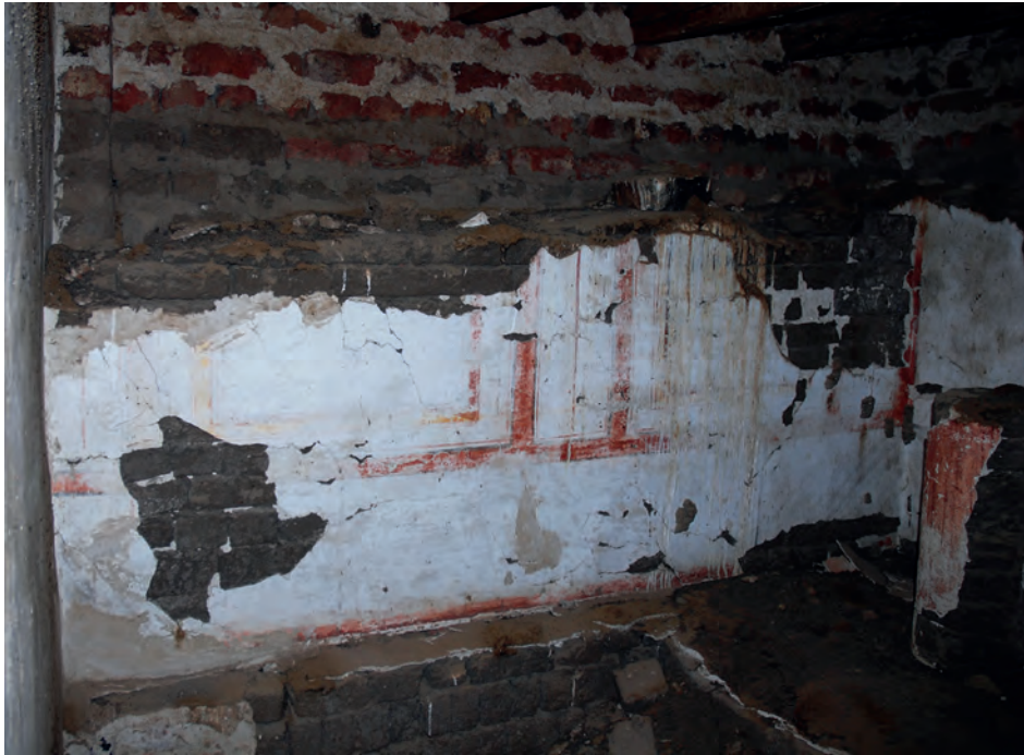
Abb. 18: Obergeschoss, 2. Raum, Westwand; 2008
