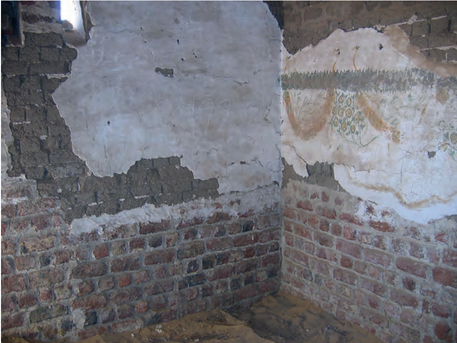
Abb. 28: Raum GB 5.2.2, Blick in die Südwestecke. Oben zu erkennen sind die Reste der originalen Wand mit Malerei, während die Wandsöckel mit gebrannten Ziegeln ergänzt wurden; 2006
