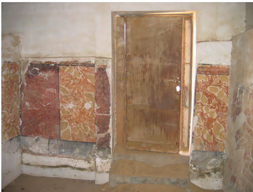
Abb. 8: Obergeschoss, 1. Raum, Nordwand; 2006
