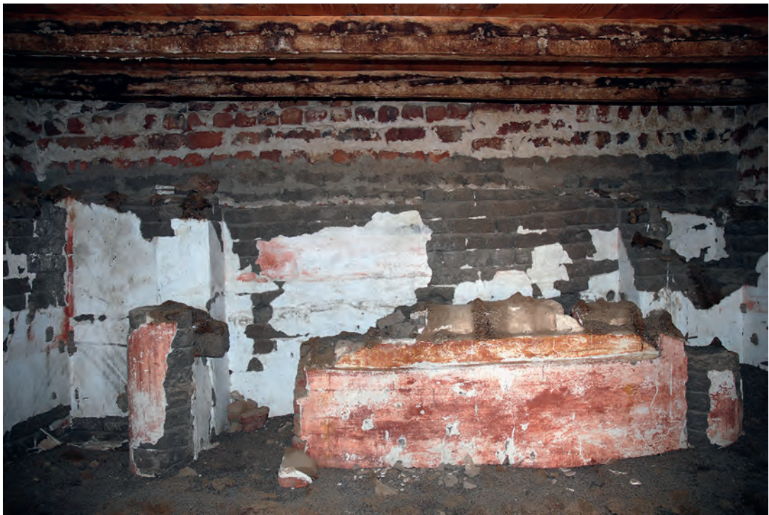
Abb. 19: Obergeschoss, 2. Raum, Nordwand; 2008
