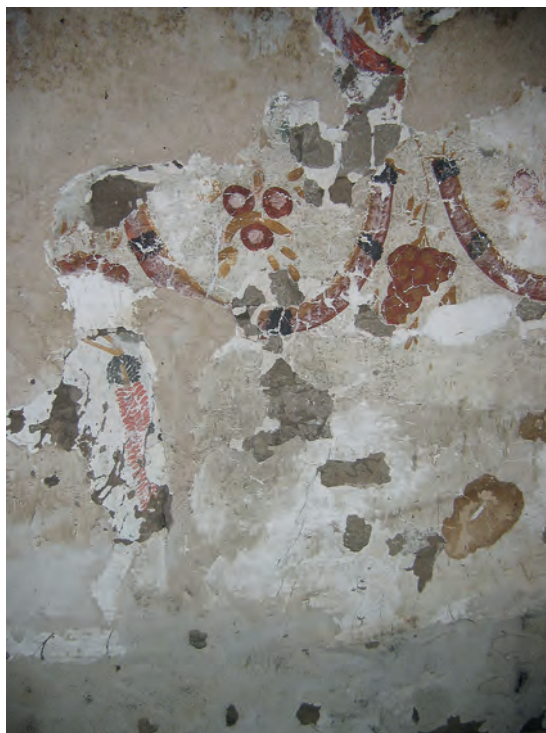
Abb. 23: Erdgeschoss, 2. Raum, Detail Nordwand; 2005
