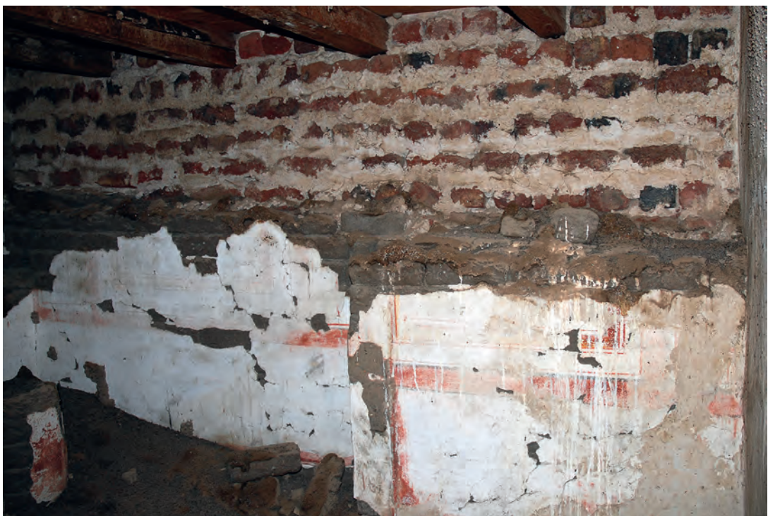
Abb. 20: Obergeschoss, 2. Raum, Ostwand; 2008
