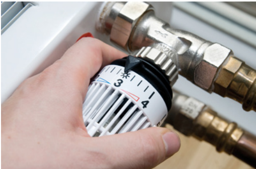
Abbildung 2: Richtige Einstellung des Thermostatkopfes
