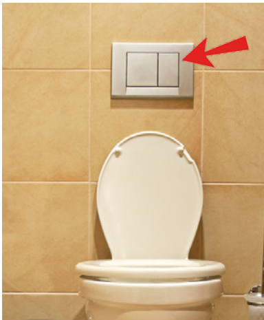
Abbildung 21: Spülkasten mit Zwei-Mengen-Spültechnik
