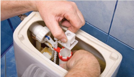
Abbildung 22: Nachrüsten einer Wasser-Stopp-Betätigung
