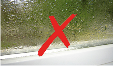
Abbildung 11: Tauwasserbildung am Fenster
