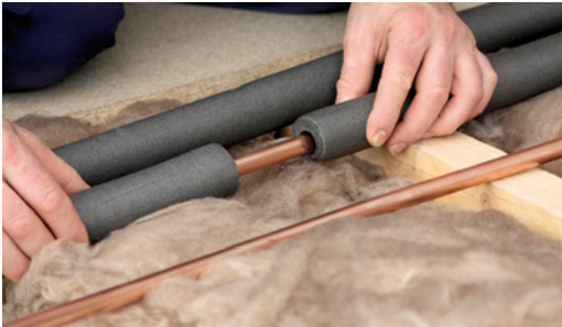
Abbildung 8: Dämmen von Rohrleitungen
