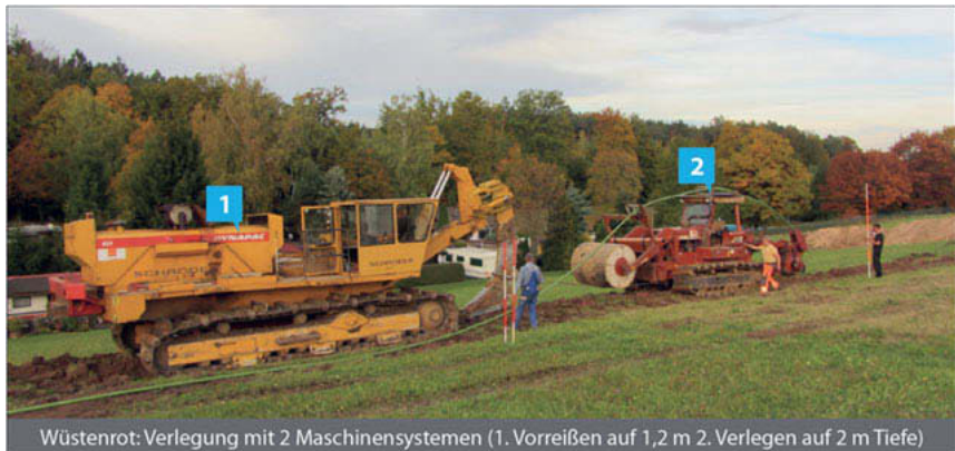
Bild 4: Einsträngige Verlegung in schwerem Boden mit Vorreißen im Zwei-Maschinensystem (Wüstenrot) [5]
