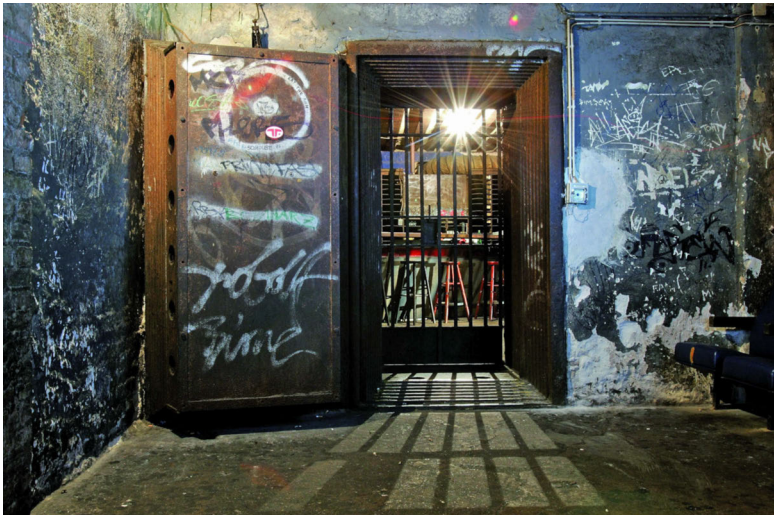
Abbildung 14: Tür zur Stahlkammer des Clubs Tresor in Berlin (Foto vom 08.02.2005).
