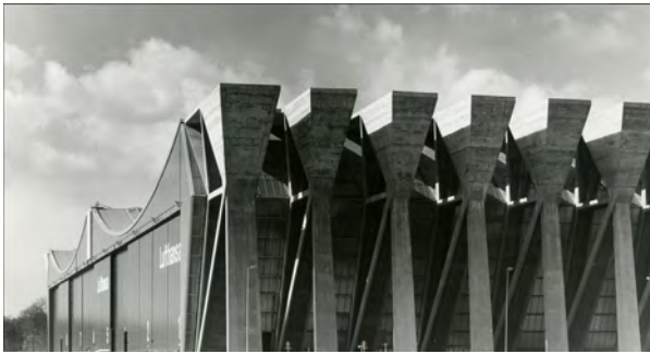
Abb. 4: Lufthansa-Wartungshalle V in Frankfurt am Main, 1972
