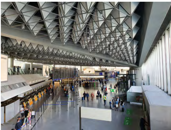
Abb. 5: Terminal Mitte/1, Airport Frankfurt am Main, Deutschland, 1972 (Foto 2021)
