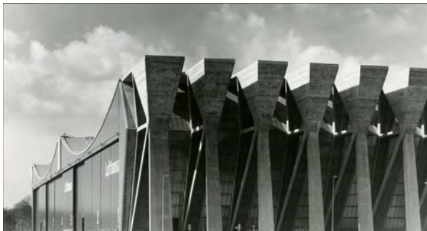
Abb. 4: Lufthansa-Wartungshalle V in Frankfurt am Main, 1972
