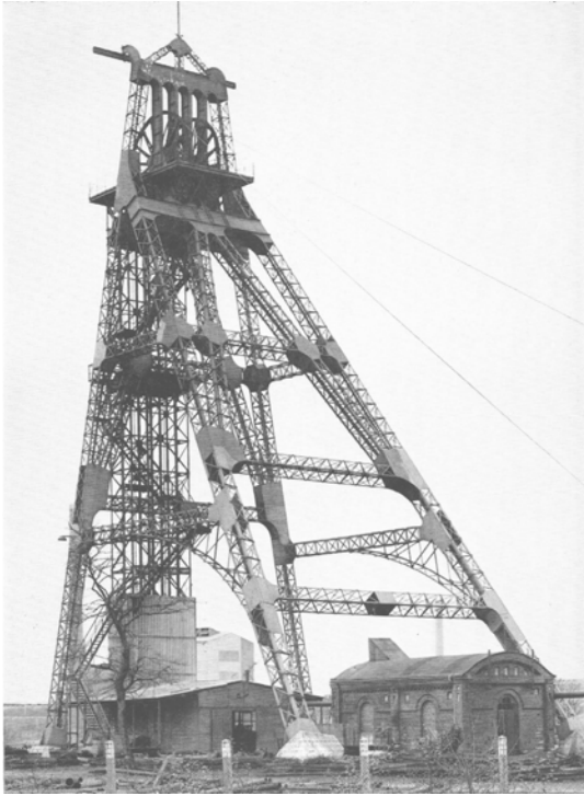
Abb. 4: Bernd und Hilla Becher, Förderstuhl Zeche Neu-Iserlohn, Schacht 3, Bochum-Werne, erbaut 1913 (abgebrochen 1969), Foto 1963.
