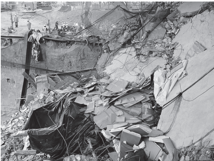
Absturz des nördlichen Magazingebäudedetails in die Baugrube der U-Bahn
