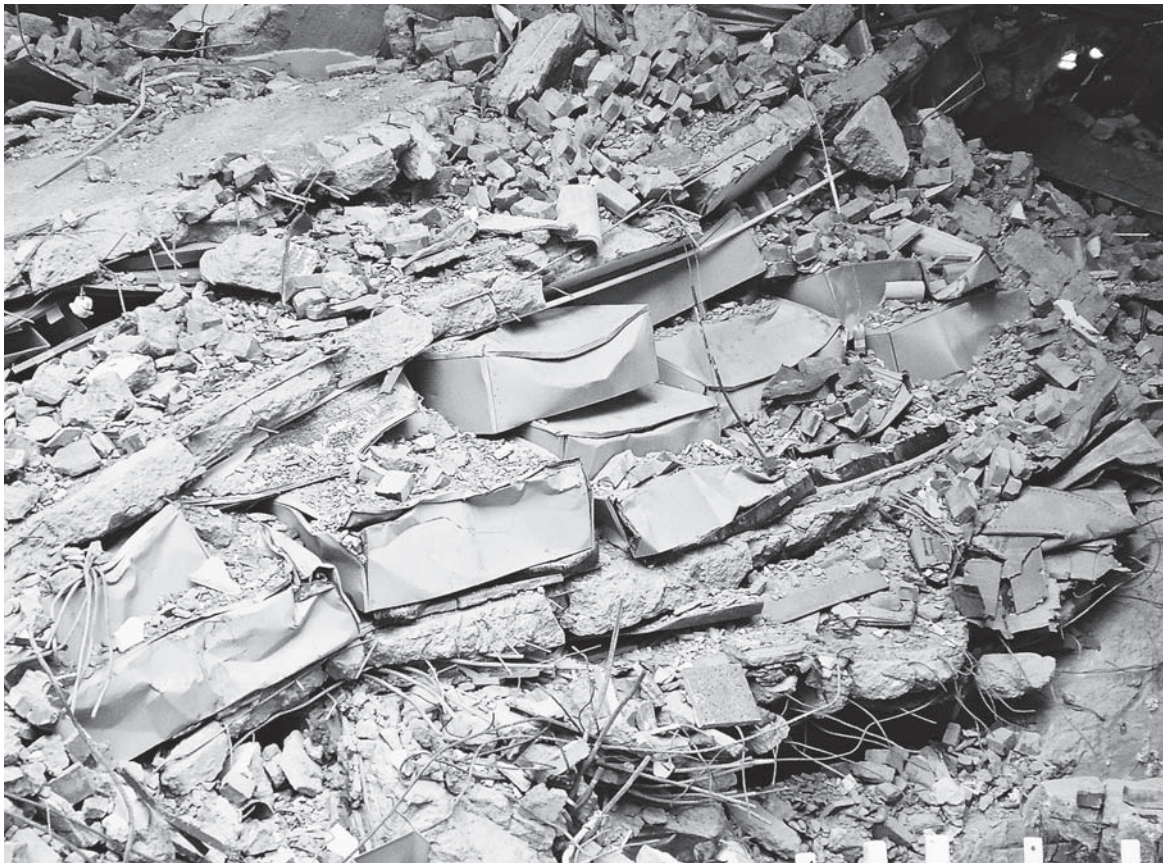
Südteil des Magazin- gebäudes mit den Geschossdecken und ein- geklemmten Schränken Foto: Neuheuser
