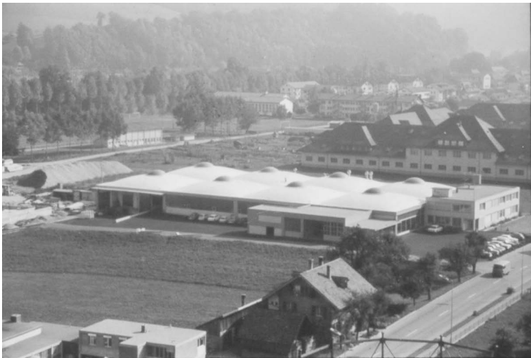
Abbildung 18: Die ausgeführten Isler-Schalen der Maschinenfabrik Kunz mit dem »Fanalon«-Kunststoffbelag, 1964. 11
