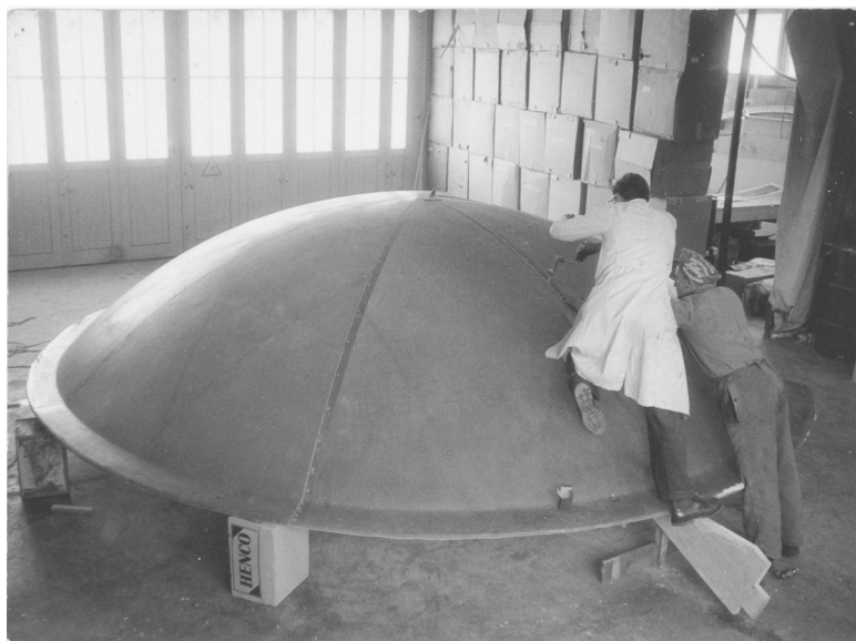
Abbildung 22: Herstellung der ersten Oberlichter Islers von der Firma Kunststoffwerke Eschmann AG in Thun, 1956. 90
