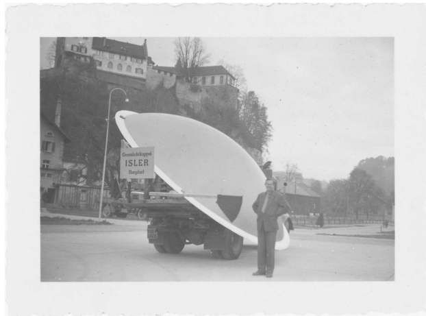
Abbildung 23: Kunststoffoberlichter System Isler. 1956 wurden sie von Heinz Isler als die grössten freitragenden Lichtkuppeln der Welt beworben. 92
