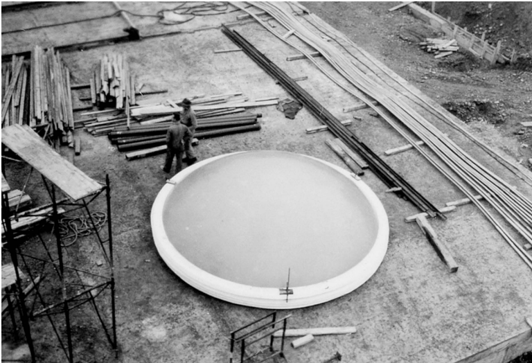
Abbildung 17: Die Kunststoffoberlichter (Mitte) und Vorspannkabel (rechts) auf der Baustelle für die Maschinenfabrik Kunz, 1961. 8
