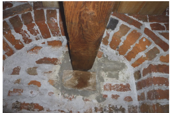
Bild 4 Brandwand mit brennbaren Bauteilen überbaut
