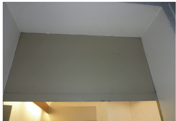
Bild 6 Vergrößerung der Feuerschutztür entspricht nicht dem Verwendbarkeitsnachweis
