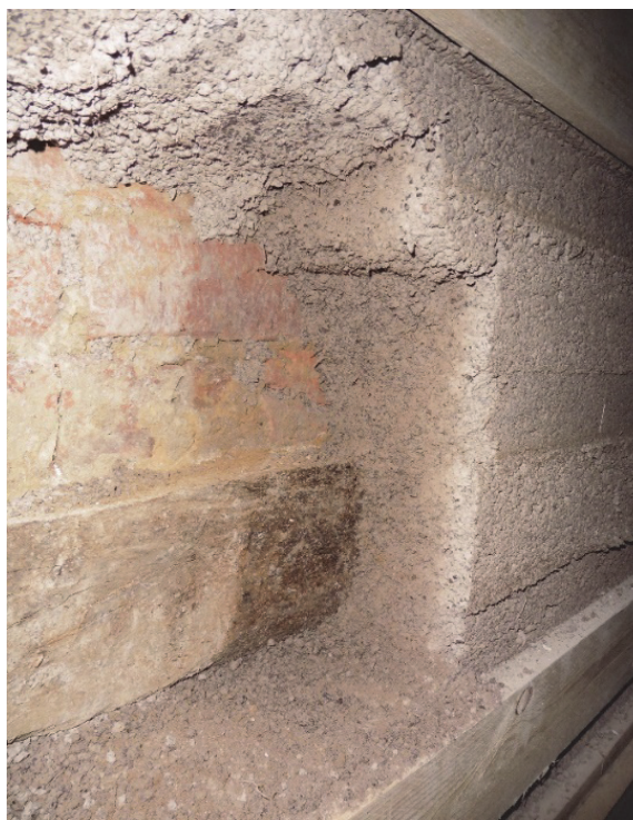
Bild 19 Abtrocknungshorizont beim Wärmedämmlehm (knapp vier Monate nach Einbau) und durchfeuchtete Hölzer. Anm.: Vorderer Bereich bereits durch frühere Bauteilöffnung abgetrocknet
