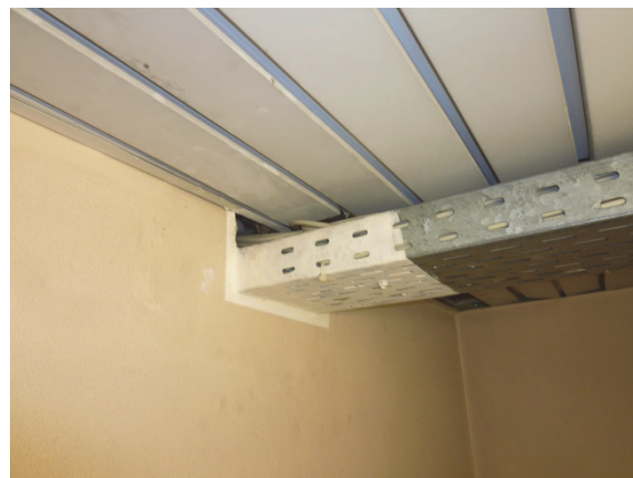
Bild 10 Fehlerhaft eingebaute Abschottung
