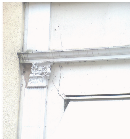
Bild 12 Schadensbilder; oben: Riss in Kellergewölbedecke, unten: Fassadenriss an der Grenze zum Neubau
