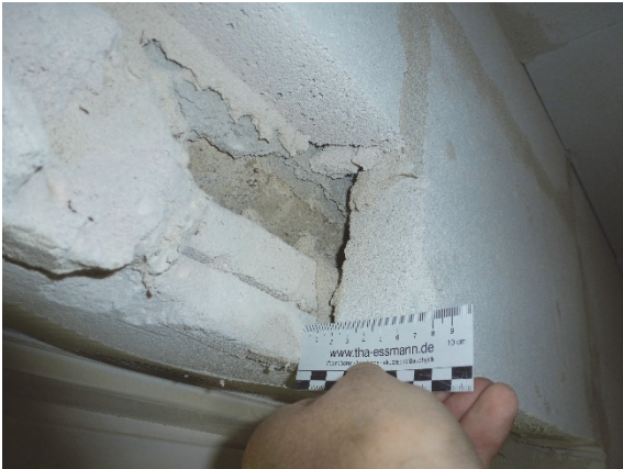
Bild 2 Hohlräume hinter einer Innendämmung aus Mineraldämmplatten (hier im Sturzbereich)
