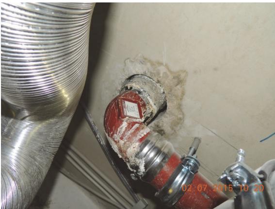
Bild 9 Wasserflecken an Ablauf (unter abgehängter Decke)
