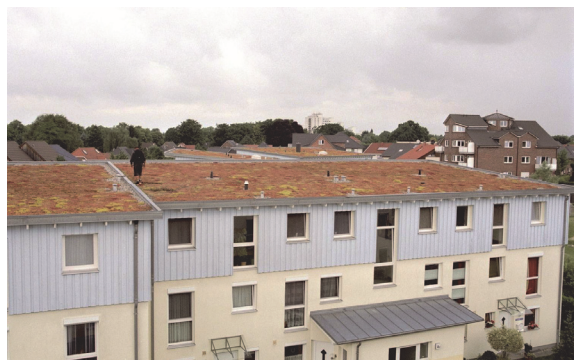
Bild 9 Ansichten der unbelüfteten Flachdächer aus Holz mit extensiver Begrünung
