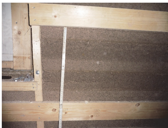
Bild 18 Feuchtehorizonte nach teilweisem Abbau der Schalung
