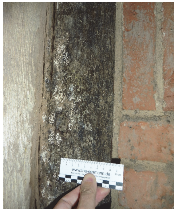
Bild 21 Pilzbildung auf den Hölzern nach Abriss des Wärmedämmlehms
