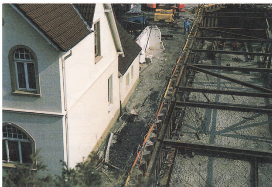
Bild 13 Baugrubensystem (oben) und Foto der Baugrube nach Einbringen der ersten Steifenlage (unten) [12]
