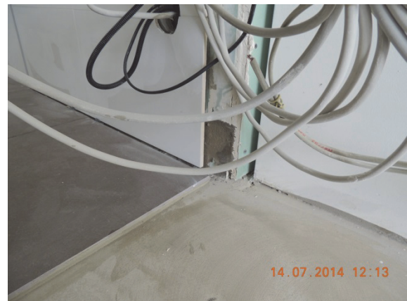
Bild 7 Fußbodenabdichtung ohne seitliche Aufkantung
