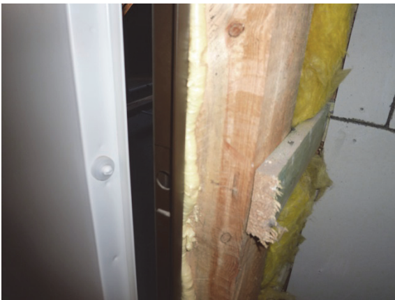
Bild 8 Nachträgliche Trockenbaukonstruktion mit Feuerwiderstand unwirksam
