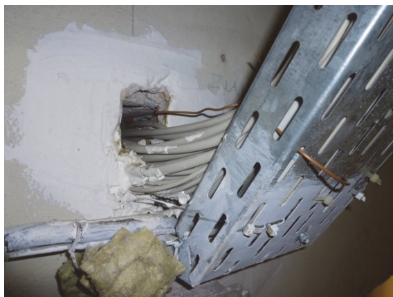
Bild 3 Ein häufiger »Klassiker«: eine unsachgemäße Kabelverlegung
