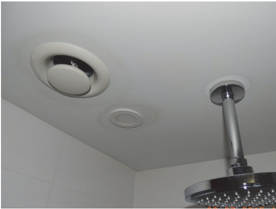
Bild 8 Wasserflecken an abgehängter Decke
