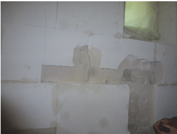
Bild 3 Hohlräume hinter einer Innendämmung aus Mineraldämmplatten (hier im ebenen Wandbereich)
