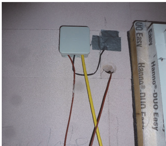
Bild 17 Einbau der Messtechnik zur Überwachung der Bauteilfeuchten
