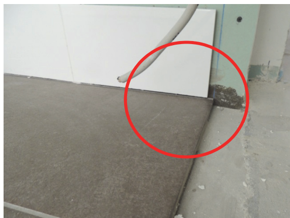
Bild 4 Fehlende seitliche Aufkantung
