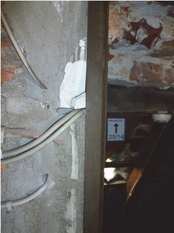
Bild 7 Abstandsregeln zur Feuerschutztür nicht eingehalten
