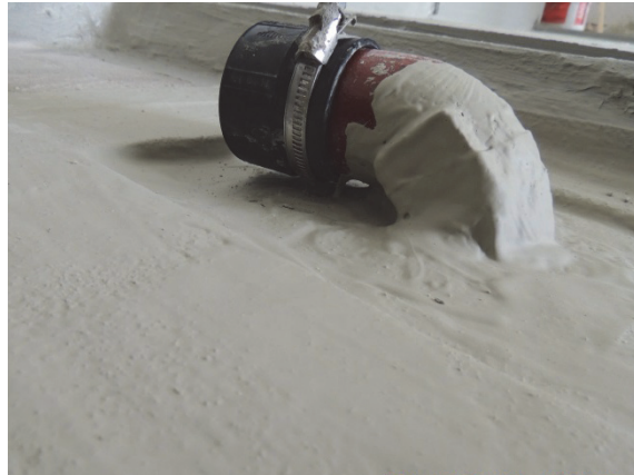
Bild 2 Fußbodenabdichtung
