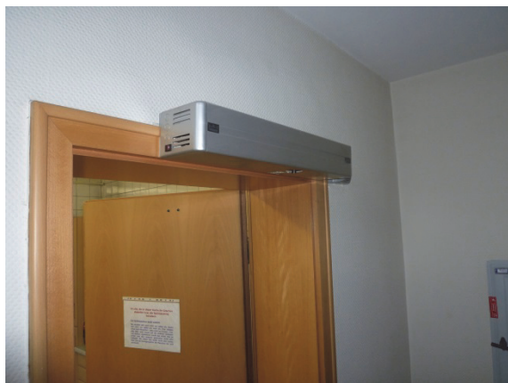
Bild 2 Mangel an einer baulichen Brandschutzmaßnahme (Tür war nicht selbstschließend)
