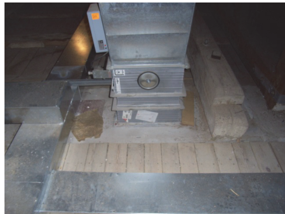
Bild 9 Abweichend von der abZ eingebaute Brand-schutzklappe
