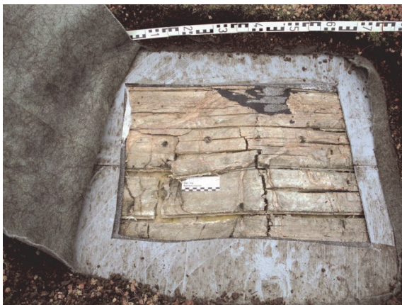
Bild 10 Öffnung der Dachabdichtung mit der verfaulten Holzschalung
