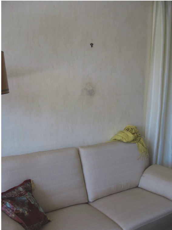
Bild 5 Feuchtedurchtritt bei Innendämmung mit Schimmelpilzbildung
