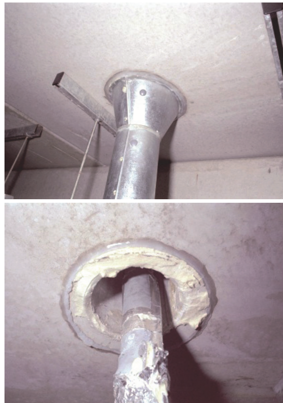
Bild 5 Öffnung des Deckendurchgangs von innen
