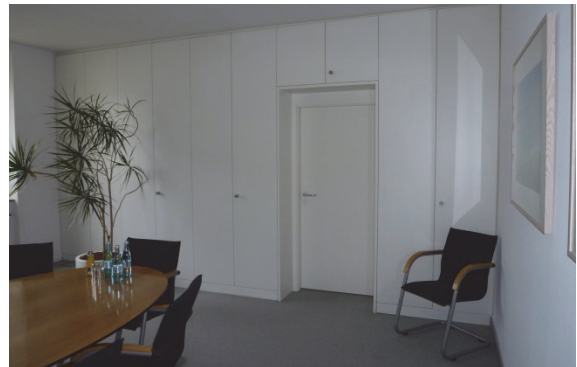
Bild 5 Vorhandenes Trennwandsystem ohne brandschutztechnische Klassifikation
