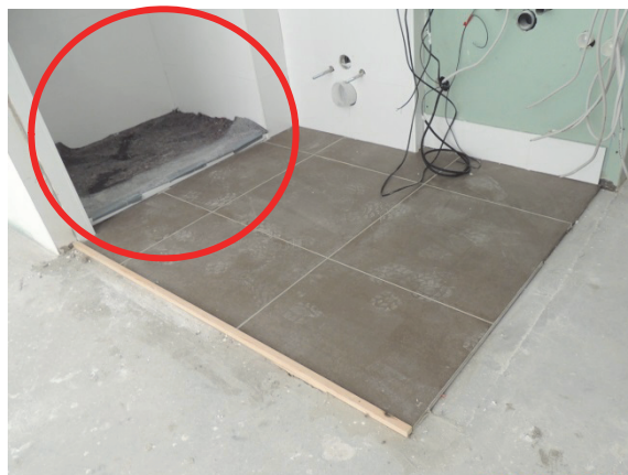
Bild 3 Vertiefung zur Aufnahme der Duschwanne
