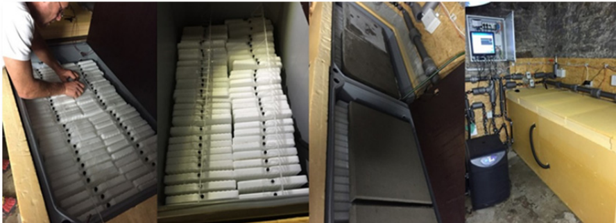
Bild 3 Einbau der PCM-Behälter
