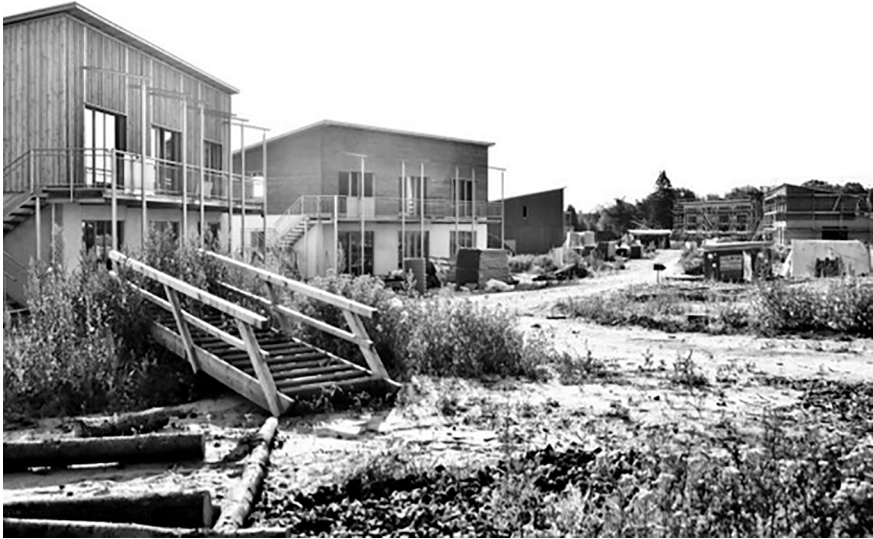
Abbildung 1: Hitzacker/DorfBaustelle, im Sommer 2019
