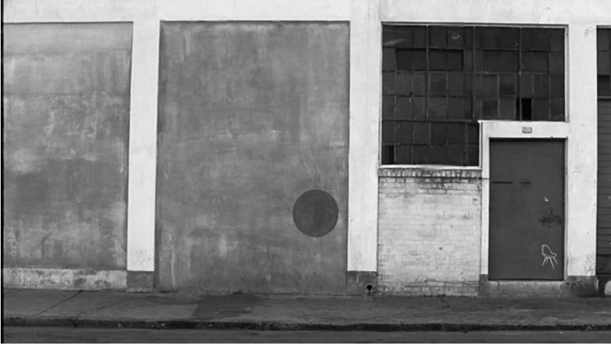
Abb. 11: Der aufgemalte Punkt auf der Fassade von Lourenços Geschäft.
