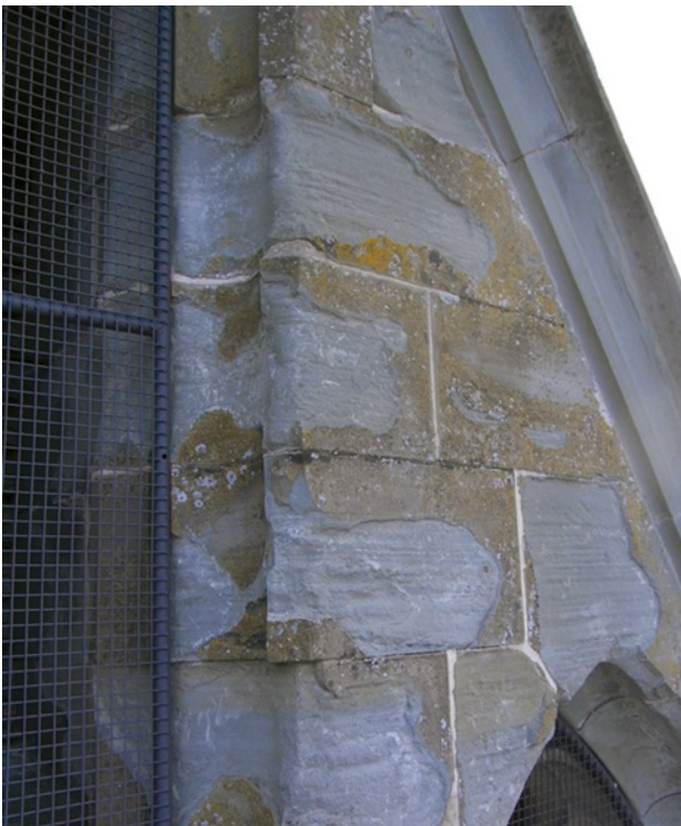
Abb. 3 a und b Häufiges Schadensbild am Molassesandstein: Schalen mit dahinterliegenden Mürbzonen, Oberflächenverlust als Folge
