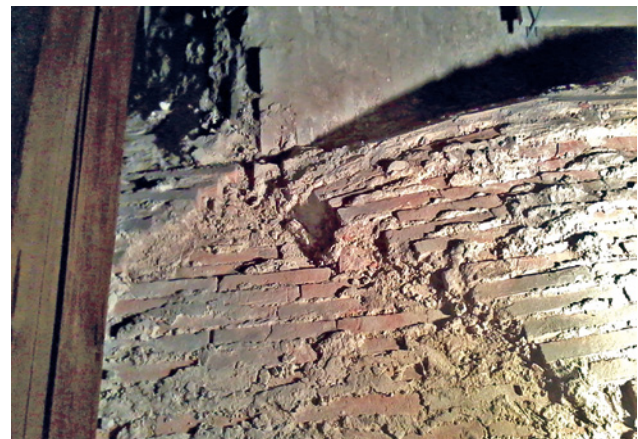
Abb. 9 Detail plastische Verformung Kappenmauerwerk am Gewölberand
