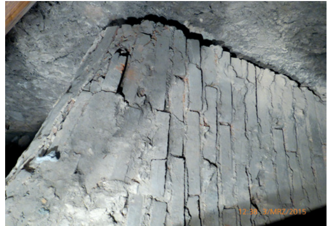
Abb. 7 Abriss der Stichkappe von der Aussenwand
