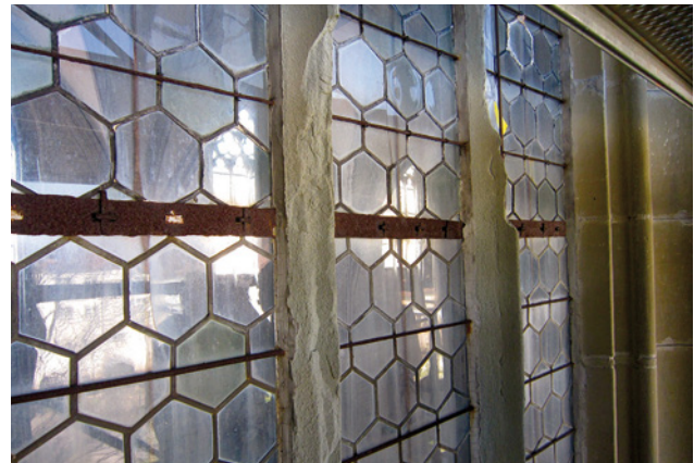
Abb. 22 Typisches Schadensbild des Molassesandsteins an den Obergadenfenster der Nordfassade des Münsters, rechts das Fugenbild mit Überarbeitungen des späten 19. Jahrhunderts
