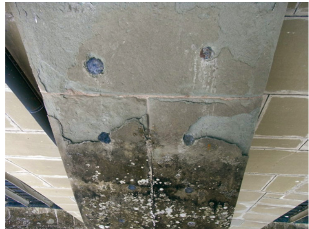
Abb. 5 Die mit Nadeln gesicherten Abdeckplatten nach 12 Jahren Standzeit
