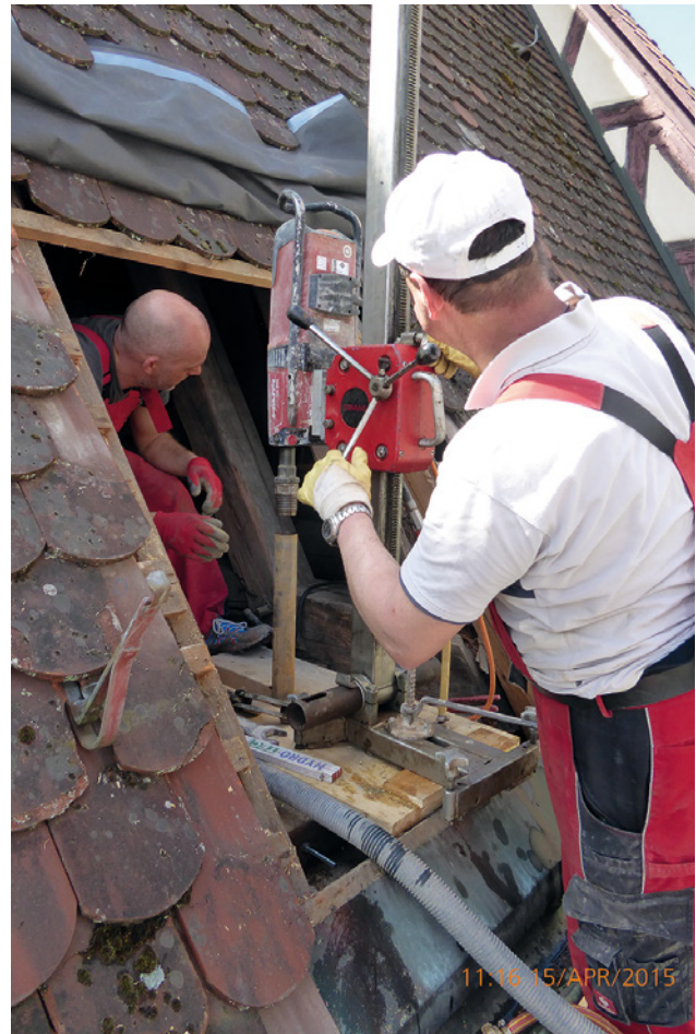
Abb. 31 Vertikal-Kernbohrungen zur Herstellung der Vertikalverankerung Mauerkrone, parallel-axial zu Strebeböfeler
