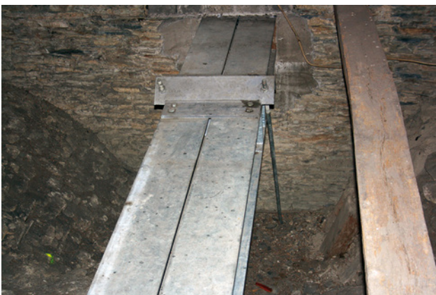
Abb. 3 Detail des Zugstabanschlusses an die beiden Stahlträger (Maßnahme 1975)
