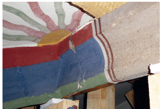
Abb. 12 Detail durchgerissene Fuge Nähe Knotenpunkt Kreuzrippe, Abplatzung am Werkstein
