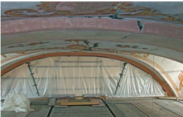
Abb. 8 Stark verformter Gurtbogen, der jetzt eine fast korbogen-ähnliche Geometrie aufweist
