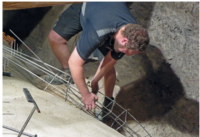
Abb. 25 Montage Edelstahlbewehrungskorb, örtliche Anpassung an den Krümmungsverlauf
