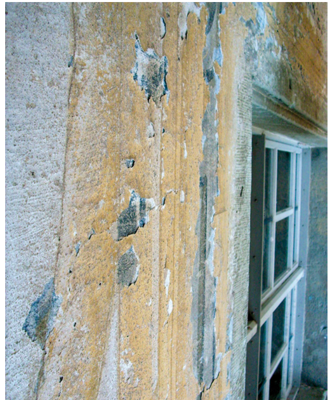
Abb. 5 Ein typisches Schadensbild, hier an einem Fenster im Tafelobstgarten: Unter der gelben Fassung von 1789 ist die bauzeitliche Freskomalerei erhalten. Die ehemals überfasste Fensterleibung in Naturstein liegt frei.
