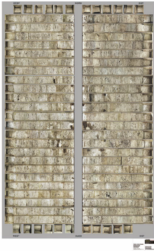
Abb. 10 Bildplan der Bockshaut, d. h. der Putzflächen im Dach, die als Verklammerung der Stuckdecke mit der Deckenkonstruktion dienen. Gesamtplan aus 312 Einzelaufnahmen
