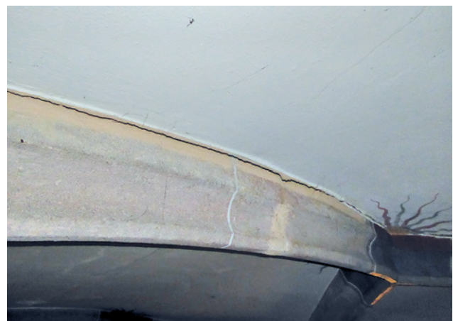
Abb. 4 Detail Ablösung der Scheitelrippen vom Hauptgewölbe
