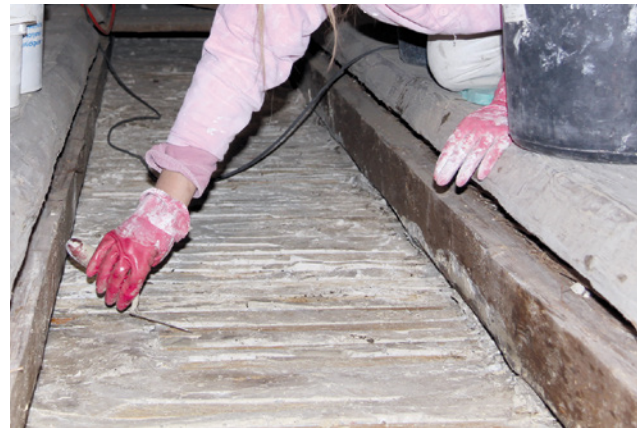
Abb. 11 Kittung der geschädigten Bockshaut in einem Balkenfeld, 2011
