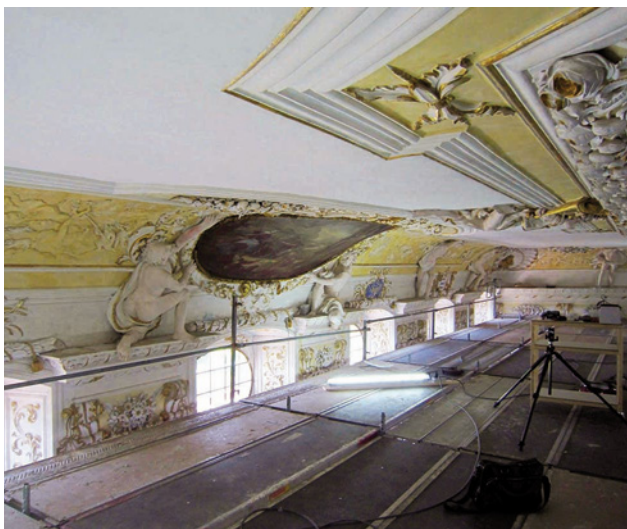
Abb. 14 Die Decke in ähnlicher Blickrichtung wie Abb. 13 nach Sicherung, Reinigung und Anbringung von leichten Retuschen zur optischen Vereinheitlichung
