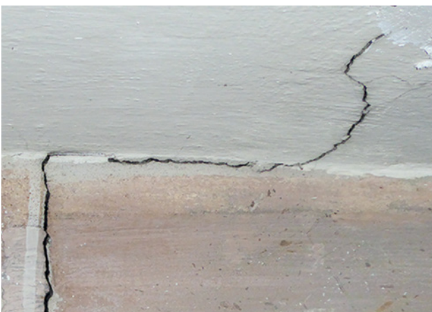
Abb. 3 Detail Scheitelrippe mit aufgemalter Scheinfuge, Fugenklaffung
