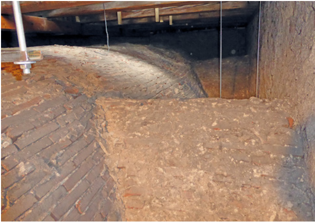
Abb. 5 Hauptgewölbe (Längstonne) mit Stichkappe
