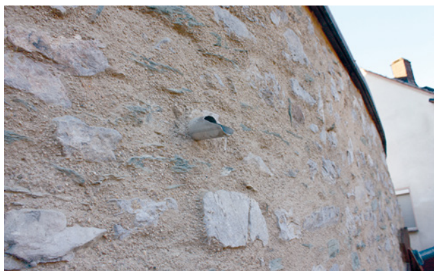
Abb. 5 Tiefenverfugte Wandfläche steinsichtig gestrahlt
