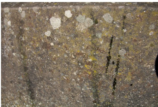
Abb. 4 Abdeckplatten des Sockels, ca. 60 % Gefälle, mit Wassertropfentest. Ergebnis: Wasser wird nicht aufgenommen sondern läuft ab, hydrophobe Oberfläche! (St. Anna-Kirche Bernhardsweiler/Fichtenau, April 2016). Biologischer Bewuchs: unten schwarz-pelzig, oben mit grünen Algen und Flechten
