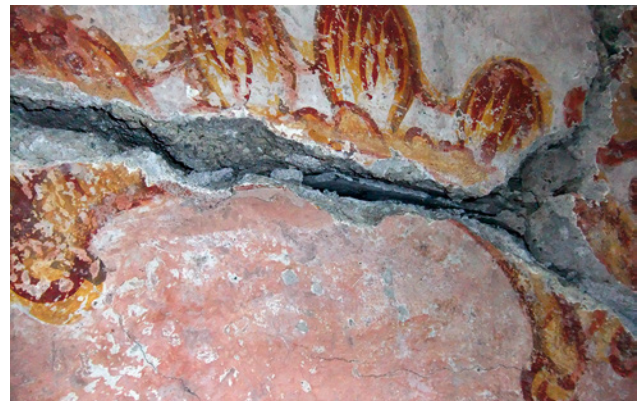
Abb. 11 Auswicklung eines Risses (frühere Sanierungsmaßnahme) mit plattigem Schieferbruchstein
