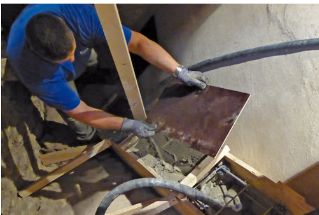
Abb. 28 Druckfeste Abdeckung der Schalungsstränge im extrem gekrümmten Bereich
