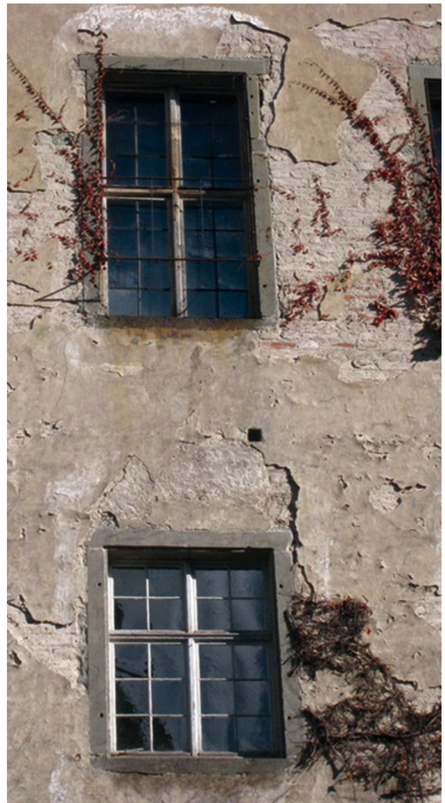
Abb. 8 d Putzflächen im Sternenhof, Vorzustand mit Bewuchsresten
