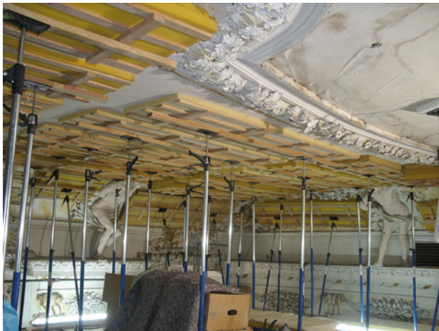
Abb. 13 Die Abspreiung der Stuckdecke zur Sicherung erfolgte in Korrelation zu dem Fortgang der Arbeiten an der Dachkonstruktion, 2010
