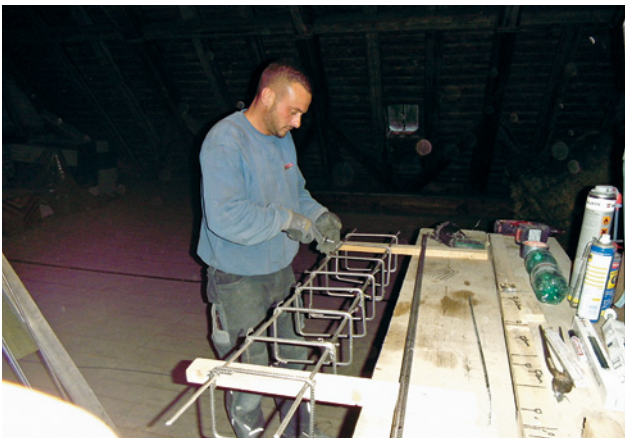
Abb. 24 Konventionelles Herstellen von Edelstahl-Bewehrungskörben
