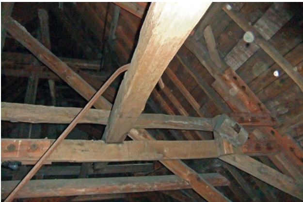
Abb. 4 Historischer Zugstabanschluss am Mittelrähm der Dachkonstruktion
