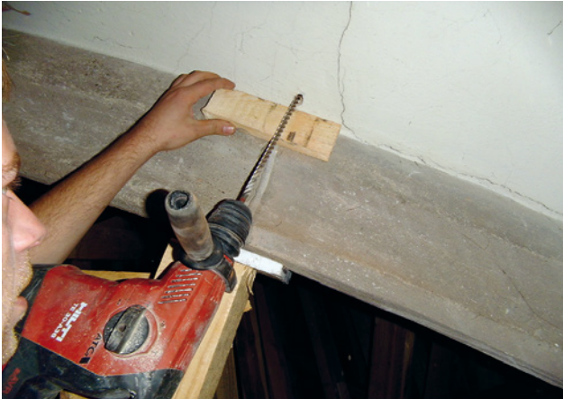
Abb. 18 Gewölbeunterseitige Sondierungsbohrungen zum exakten Verlauf Kreuzrippen
