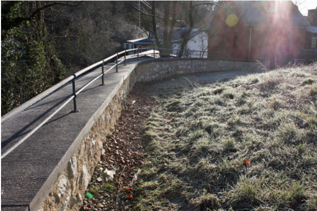
Abb. 8 Mauerkronenabdeckung aus Beton
