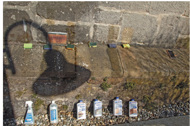
Abb. 5 Beprobung aller hydrophoben Oberflächen und Reinigungsversuche am 20.4.2016, übliche chemische Reiniger, Sockel der Südfassade St. Anna-Kirche Bernhardsweiler (Fichtenau). Zustand während der Reinigung
