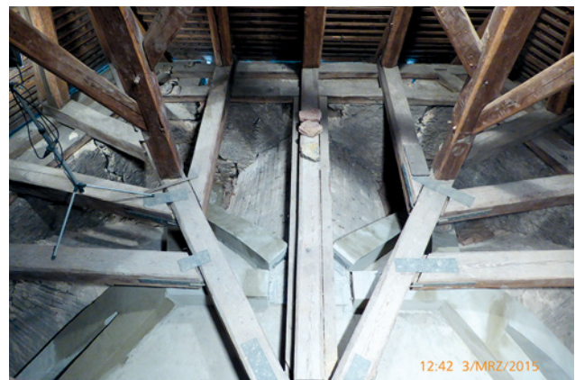
Abb. 29 Oberlastrippen ausgeschalt mit Edelstahlblech-Knotenpunkt am Chorende, Risse Mauerkrone
