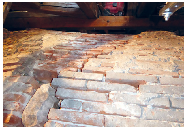
Abb. 16 Längsverformungen und Abrisse des Hauptgewölbes (Längsstone)
