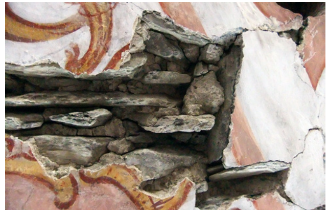
Abb. 10 Mauerwerksstruktur des Gewölbes
