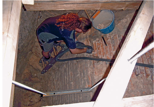
Abb. 15 Ausräumen desolater Fugen Ziegelmauerwerk
