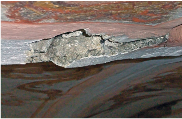
Abb. 7 Detail einer geschädigten Gratrippe mit klaffendem Riss
