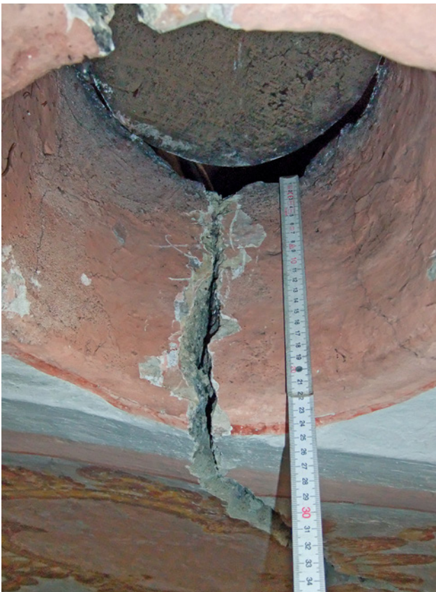
Abb. 9 Scheitelöffnung mit Rissbildung; „Gelenkbildung“ am Extrados; Gewölbedicke ca. 24 cm
