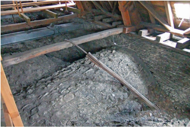
Abb. 2 Frühere Sicherungsmaßnahmen durch Rückverankerung der Strebepfeiler in den Dachraum
