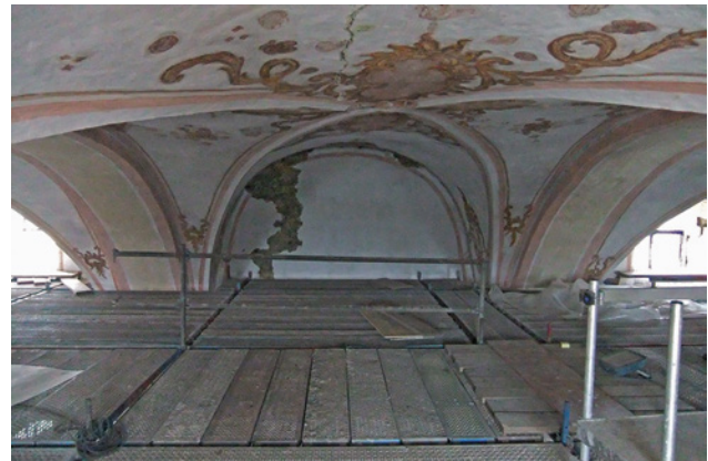
Abb. 6 Gewölbefeld mit deutlichen Verformungen und Rissbildungen
