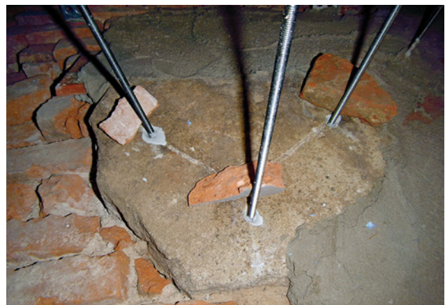
Abb. 21 Detail Schluss-Stein mit eingeklebten V2A- Gewindestäben – Rückverankerung 3-fach
