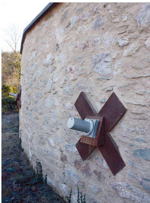
Abb. 7 Endverankerung
