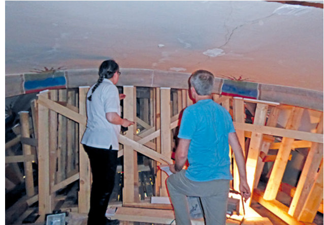
Abb. 10 Räumliches Abstützgerüst, Parallelriss-System Unterseite Scheitel
