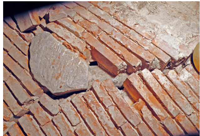
Abb. 17 Detail Schluss-Stein, Kappenmauerwerk ungenügend aufliegend auf Schulter der Steinrippen, starke Verformungen
