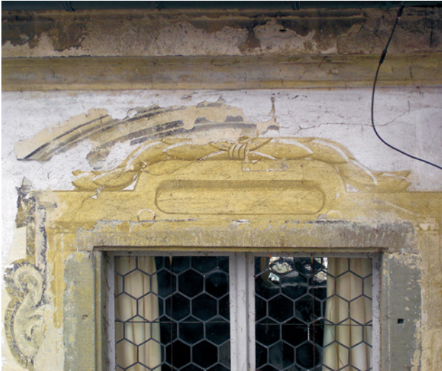
Abb. 8 a Gleichzeitigkeit von Fassungsbefunden an einer Fassade des Sternenhofes
