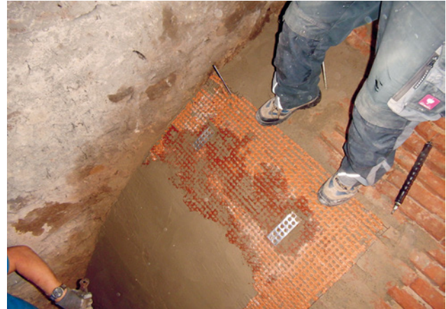
Abb. 23 Umlegen und Verdübeln der Arretierungen aus MOSO-Lochband, Aufbringen Decklage Gewölbe-Putz-System
