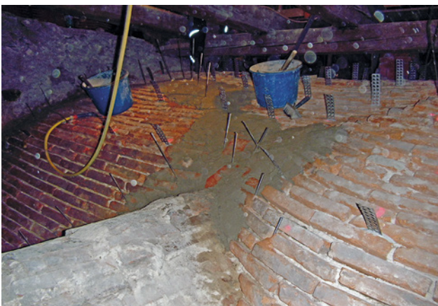
Abb. 20 Ausgleich sehr grober Fehlstellen Ziegelmauerwerk Längs- tonne Anschluss Stichkappe
