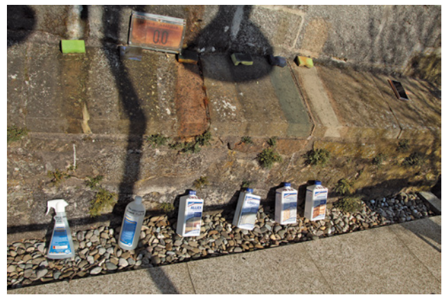
Abb. 6 Musterfelder und Erfolgskontrolle des Zustandes nach der Reinigung am 20.4.2016, verschiedene chemische Reiniger, Südfassade St. Anna-Kirche Bernhardsweiler (Fichtenau)
