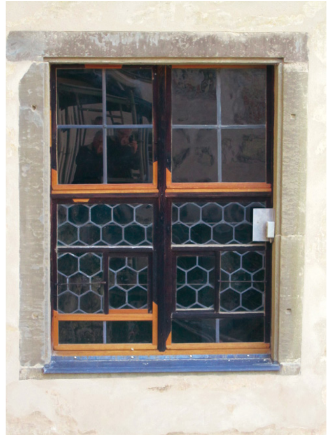
Abb. 10 Das letzte erhaltene bauzeitliche Fenster. Noch fehlt der Anstrich und die erneuerten Holzelemente treten deutlich hervor.
