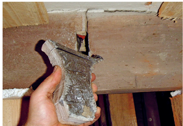
Abb. 11 Lockere Reparaturverbleiung in der Stoßfuge Scheitelrippe
