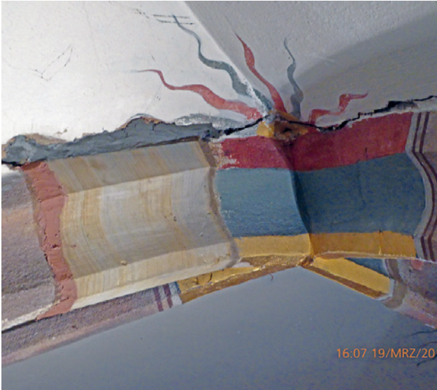
Abb.33 Eingebaute profilierte Vierung, Verdämmung der Abrisse der Rippensteine
