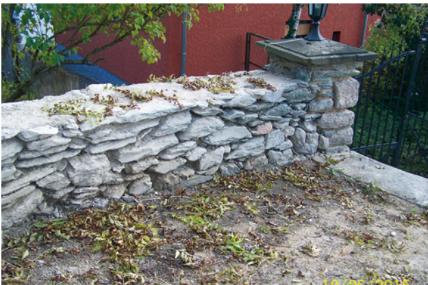
Abb. 10 Nach dem Reinigen und Aufmauern
