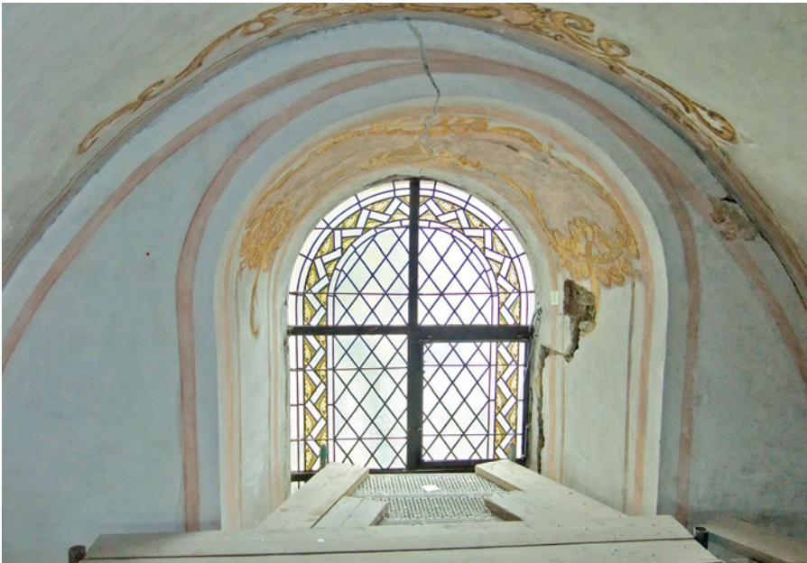
Abb. 14 Verschobene Lage eines Fensters in der südlichen Schildwand
