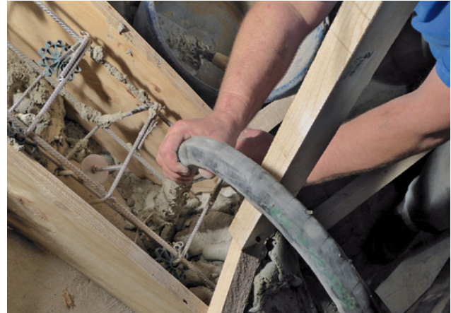
Abb. 27 Verfüllen und Verdichten des Leichtmauermörtels LM 36
