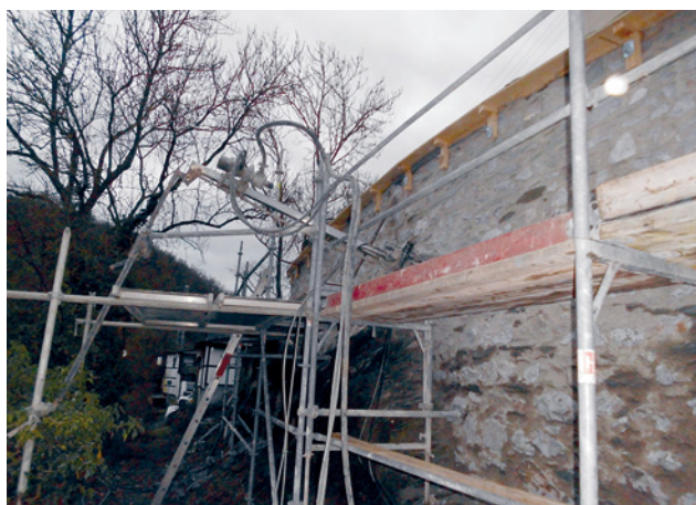
Abb. 6 Ankerbohrung
