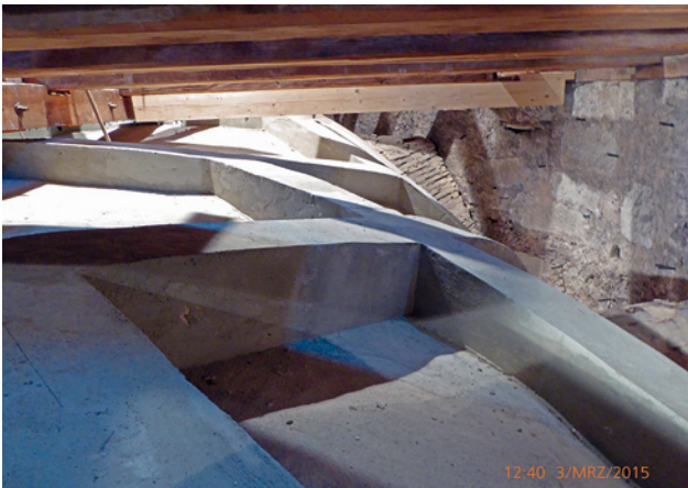
Abb. 30 Oberlastrippen ausgeschalt seitlicher Chorbereich
