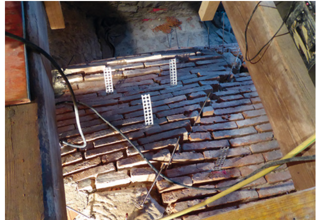
Abb. 19 Einbau Rückverankerung Kreuzrippen und MOSO-Lochband zur Putzträger-Arretierung
