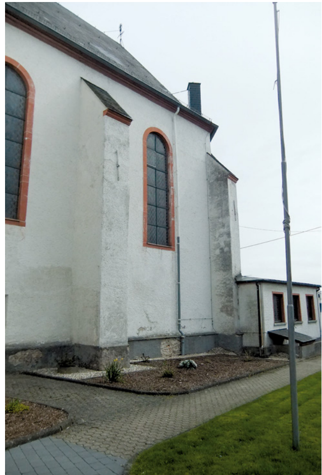
Abb. 5 Strebepfeiler an der Nordseite mit deutlich sichtbaren Splinten der Zugverankerungen
