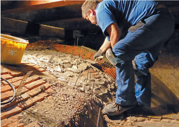
Abb. 22 Fugenverfüllung, Aufbringen Egalisierlage, Eindrücken Edelstahl-Ziegeldrahtgewebe STAUSS
