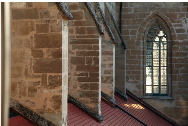
Abb. 4 Obergaden der Südseite im Vorzustand. Zu erkennen sind Fassungsreste in der gesamten Fläche und die Überfugung der geschädigten Steinkanten.
