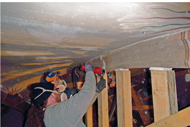
Abb. 32 Vorbereitungsarbeiten zum Einsetzen von Kreuzrippen-Vierungen
