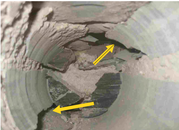
Abb. 4 Hohlraumreiches Grauwacke-Bruchsteinmauerwerk
