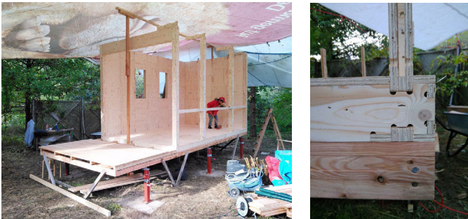
Abb. 80/81: Aufbau des ersten CNC-OS-Tiny-House-Prototyps.
