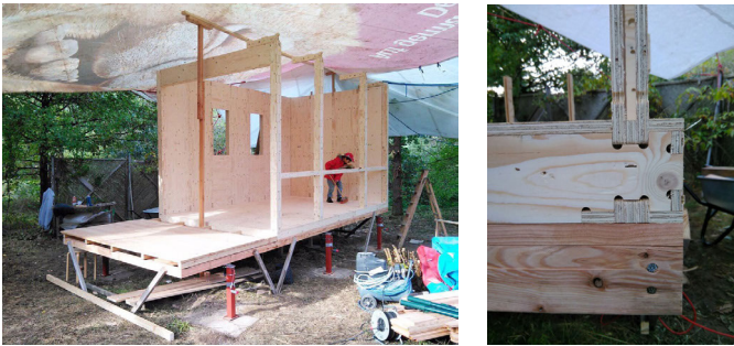
Abb. 80/81: Aufbau des ersten CNC-OS-Tiny-House-Prototyps.
